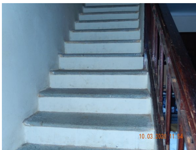
Scala accesso piano terra
