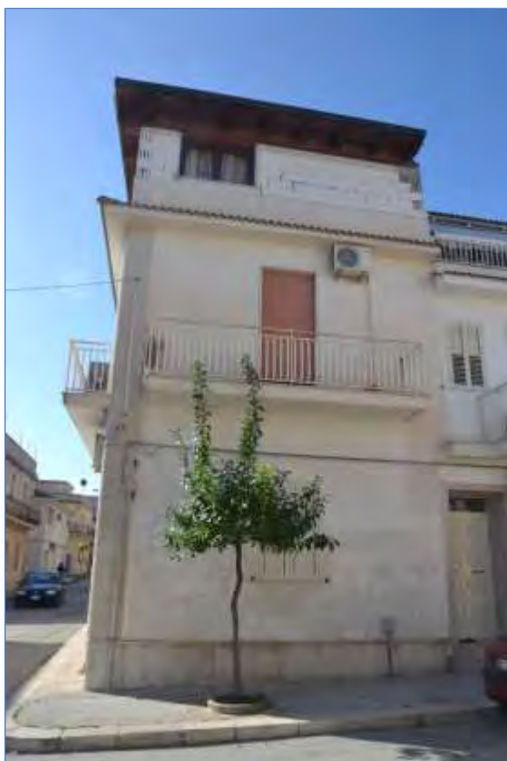
Fot.n°15: prospetto su Via Sipione
