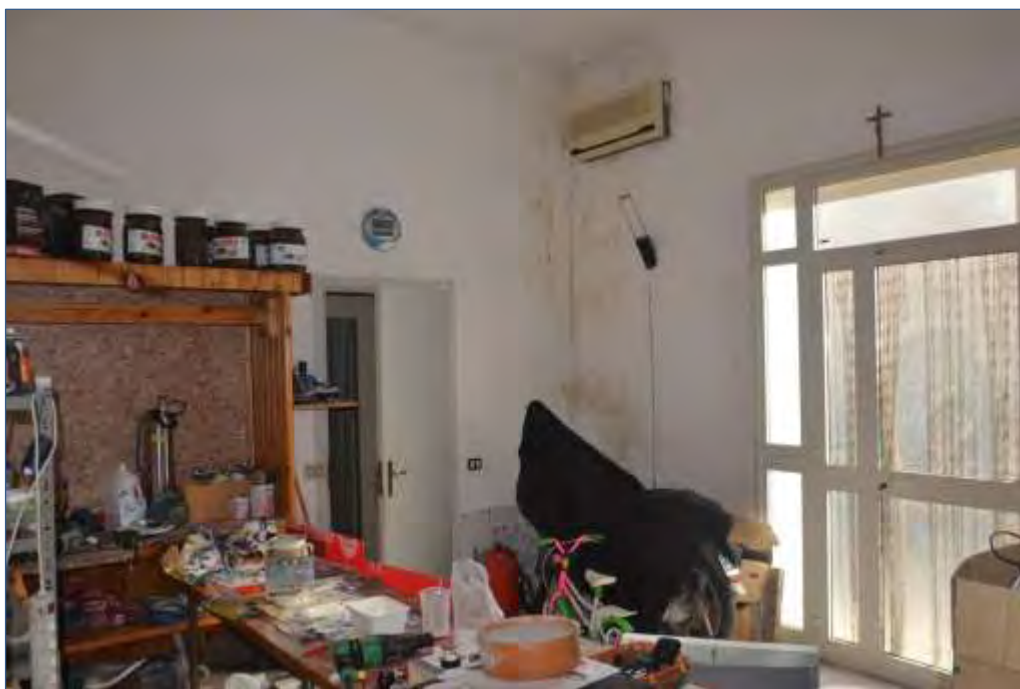
Fot.n°7: vano principale destinato ad attività commerciale.
