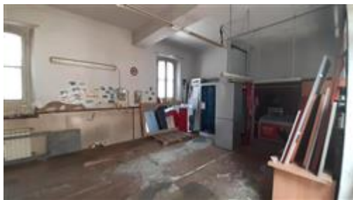
Viste interna magazzino / deposito
