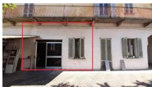
Vista esterna del deposito / magazzino - Verso cortile interno
