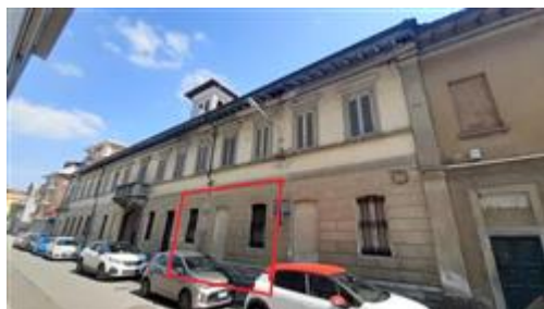
Vista esterna del deposito / magazzino - Verso via Melegnano
