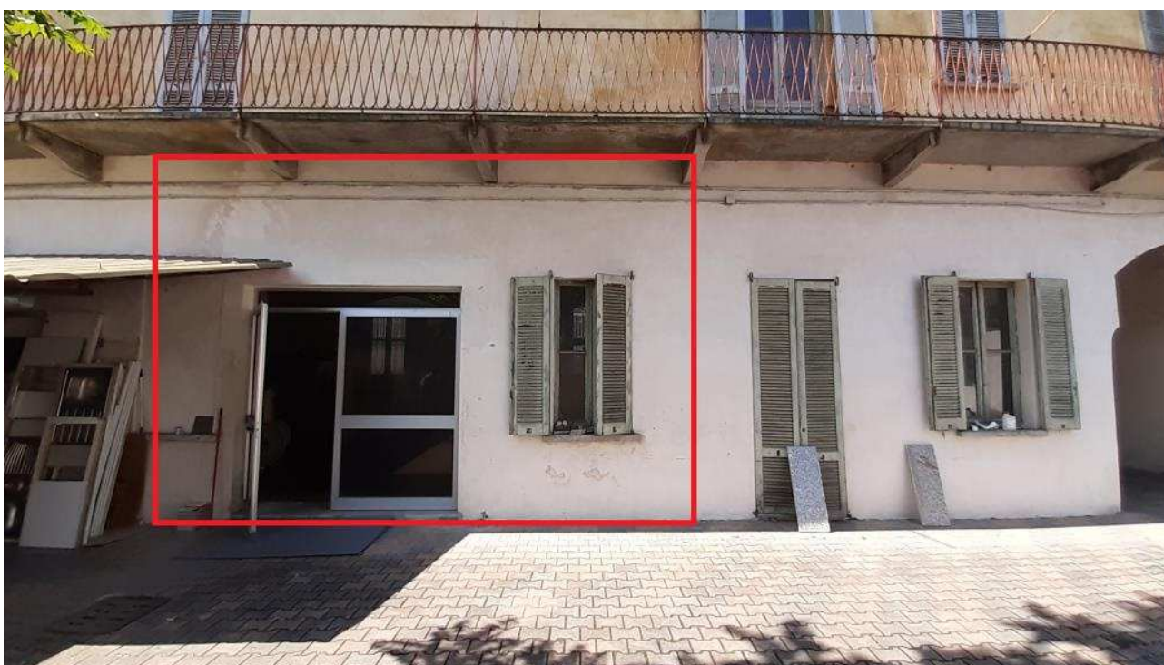
Vista dal cortile interno della porzione corrispondente alla u.i. oggetto di stima
