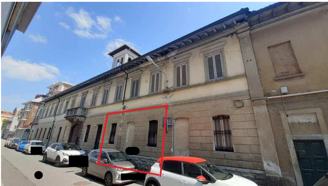
Vista dell'edificio, su via Melegnano, con individuazione della porzione corrispondente alla u.i. oggetto di stima
