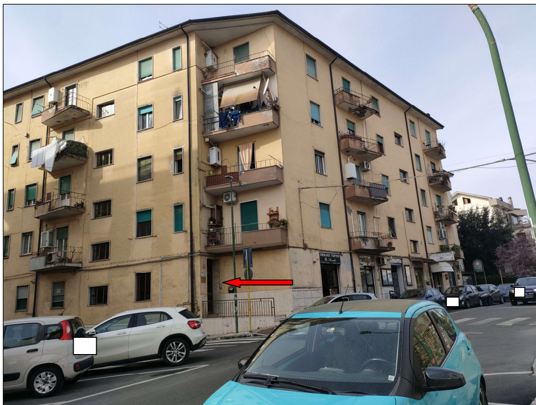
Fotografia numero 1 - Vista Esterna del Maggior Fabbricato da Via Consolare Latina, dove sono Posti I Beni Immobili Oggetto della Presente Perizia Immobiliare.
