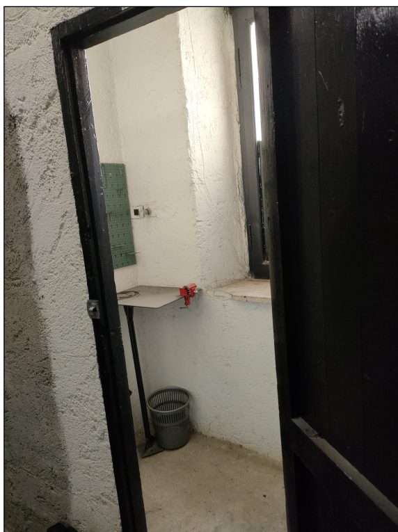
Fotografia numero 13 – Vista ravvicinata di Piccola Porzione della cantina al Piano Terra.
