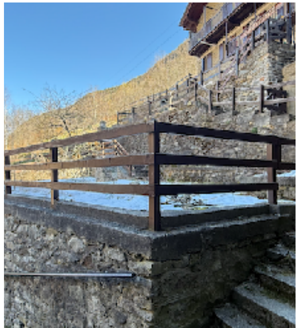
Area su particella 199
