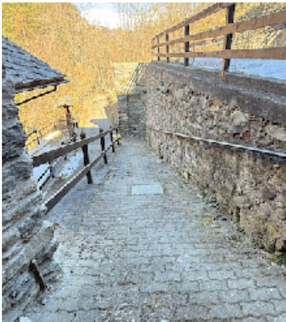
Rampa di accesso su particella 383
