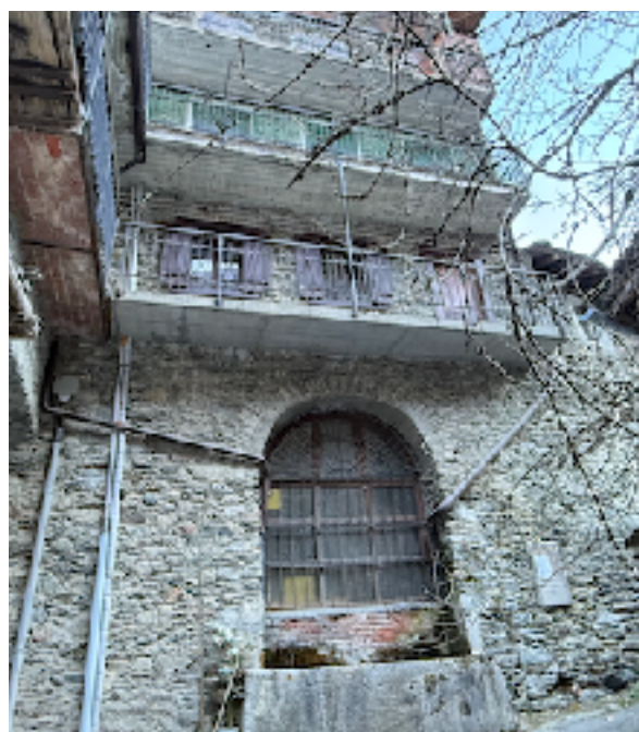
Facciata lato est
