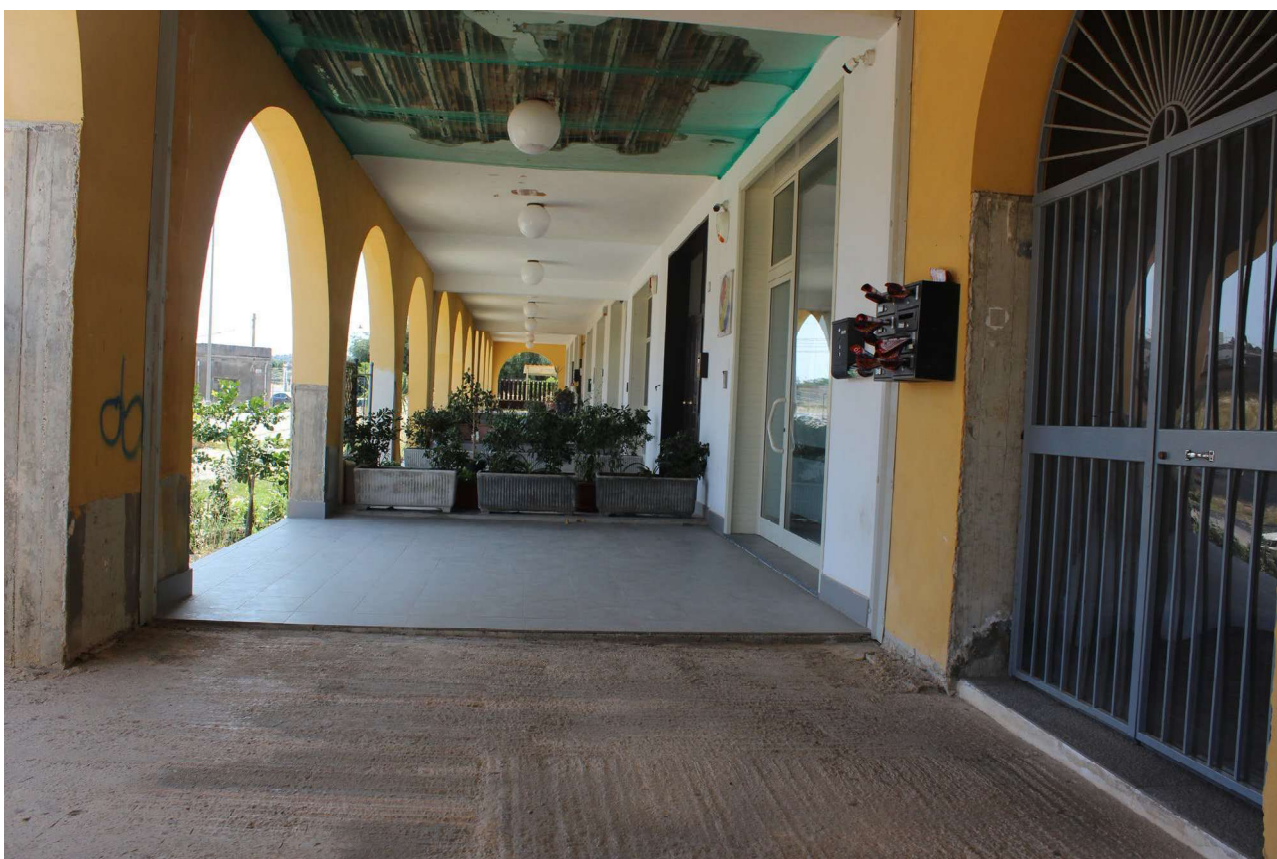
Foto n. 6 – Vista portico porzione rifinita - U.I. F.43 part.ile n.ri 18-19-20-21-22-23-24-25-26
