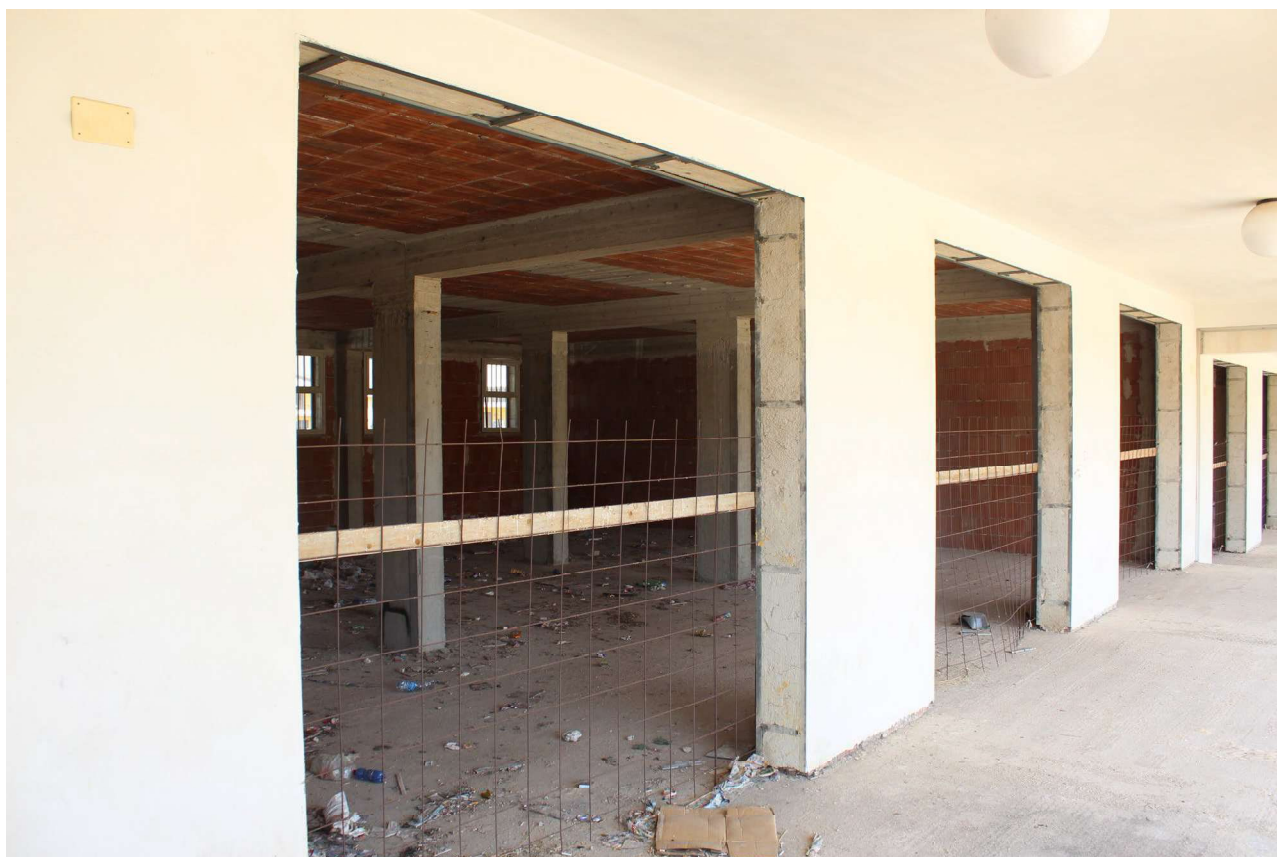
Foto n. 3 – Vista locali in corso di definizione - U.I. F.43 part.ile n.ri 18-19-20-21-22-23-24-25-26
