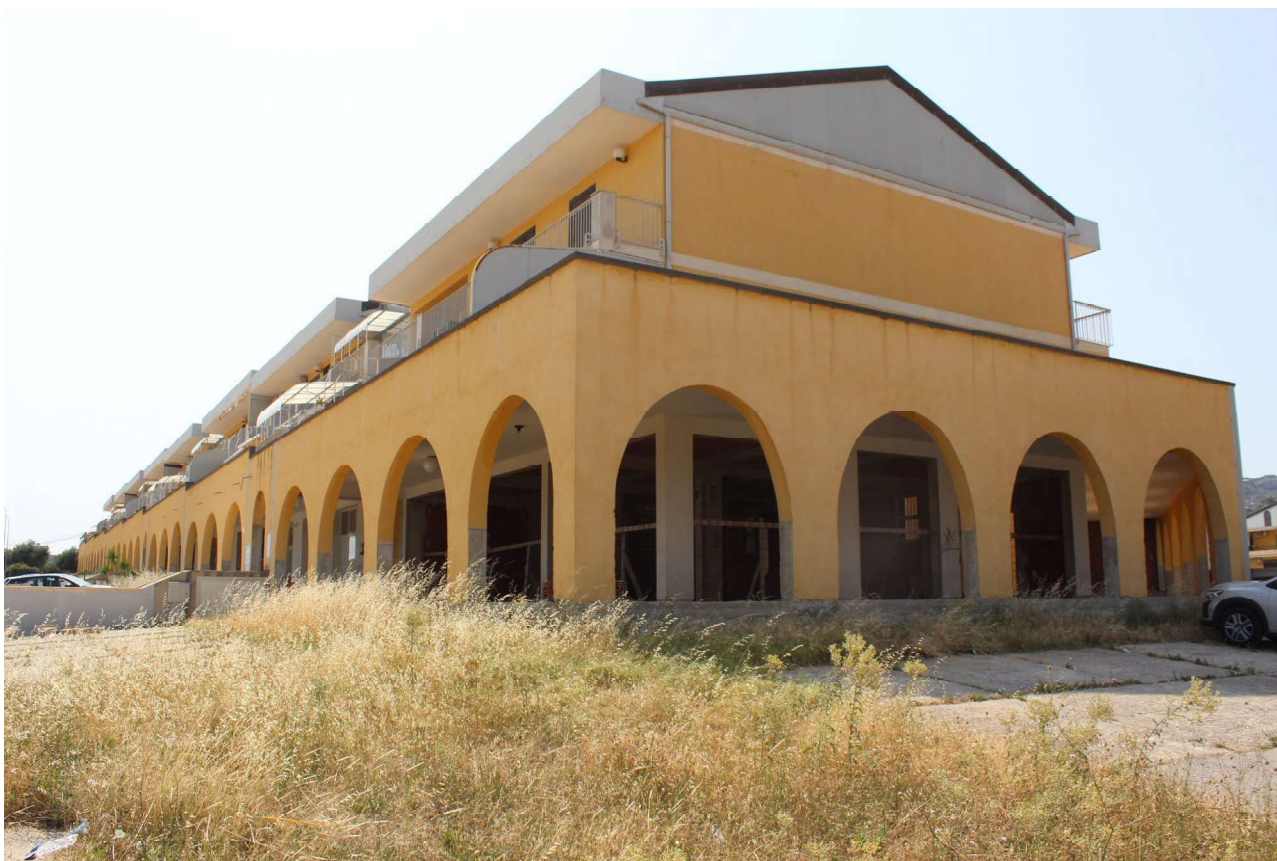
Foto n. 9–Vista del complesso condominiale dove si insistono le U.I. F.43 part.ile n.ri 18-19-20-21-22-23-24-25-26
