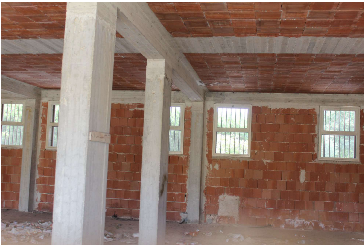
Foto n. 8 – Vista locali interni - U.I. F.43 part.ile n.ri 18-19-20-21-22-23-24-25-26
