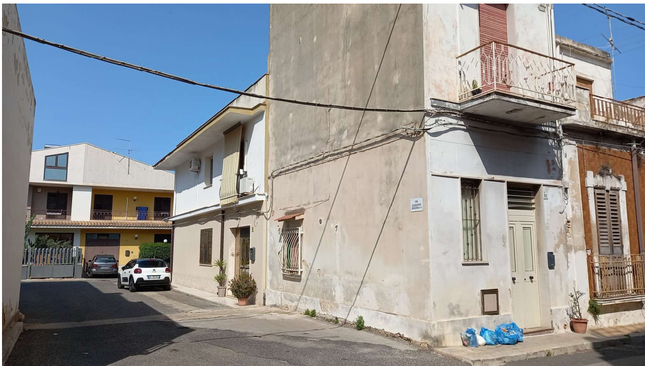
Foto n. 15 – Vista F.80 part.Ila n.5720 via Ungaretti
