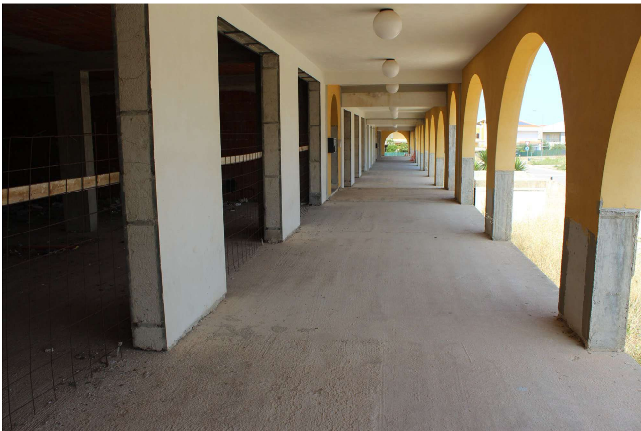
Foto n. 5 – Vista portico ingresso locali - U.I. F.43 part.ile n.ri 18-19-20-21-22-23-24-25-26
