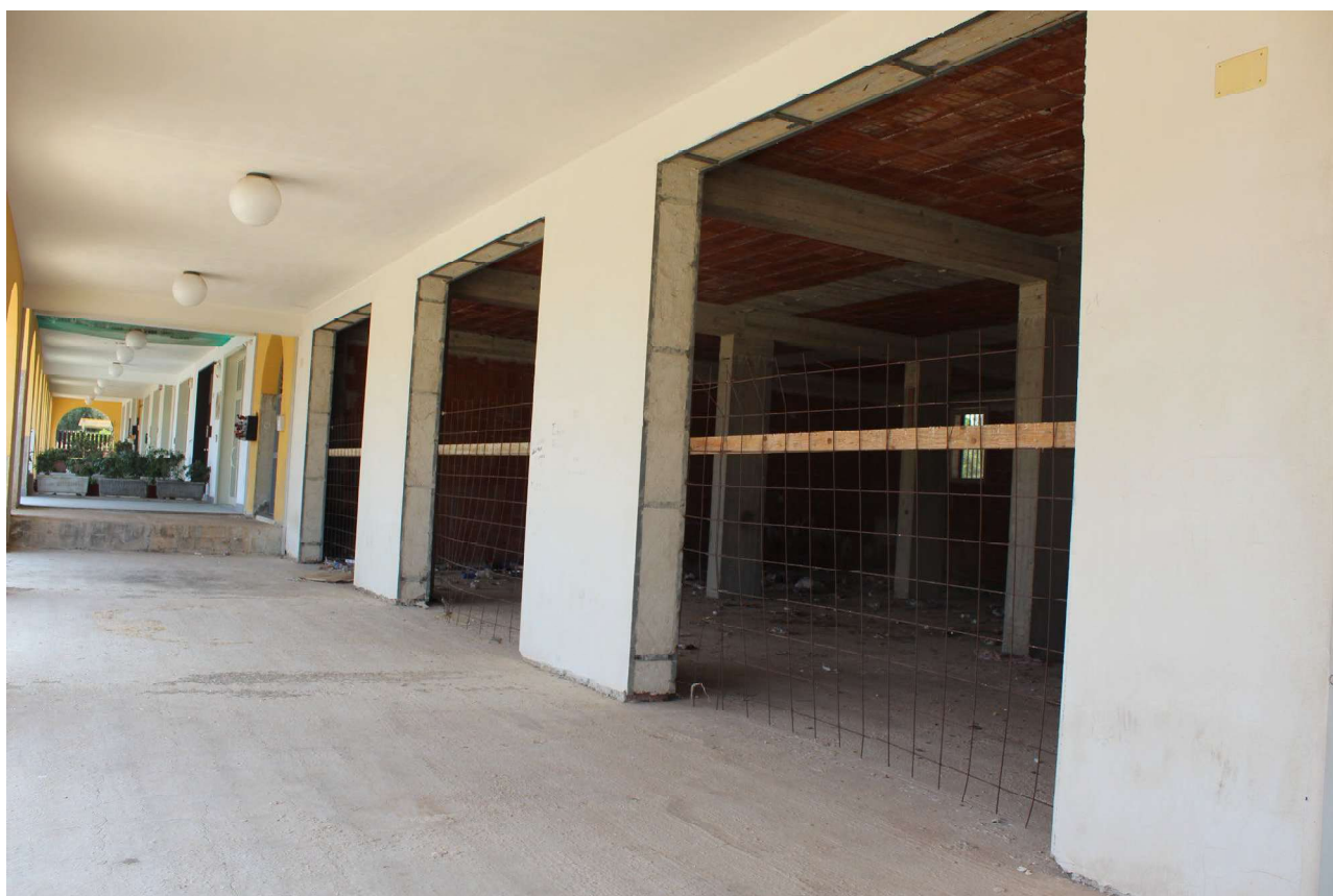
Foto n. 4 – Vista locali in corso di definizione- U.I. F.43 part.ile n.ri 18-19-20-21-22-23-24-25-26
