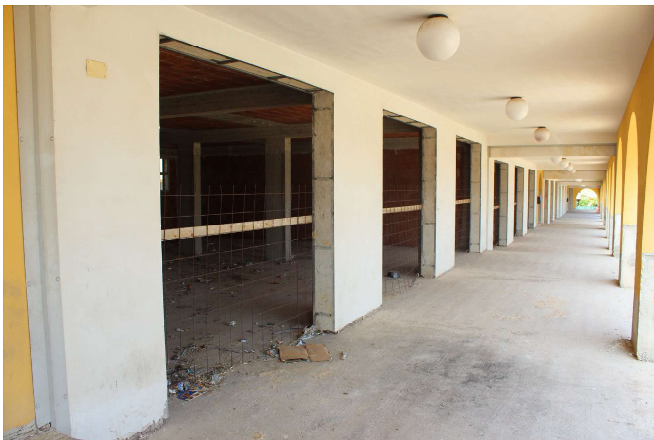
Foto n. 2 – Vista Portico e locali - U.I. F.43 part.Ile n.ri 18-19-20-21-22-23-24-25-26
