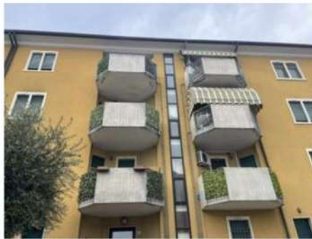
2 prospetto sud edificio principale
