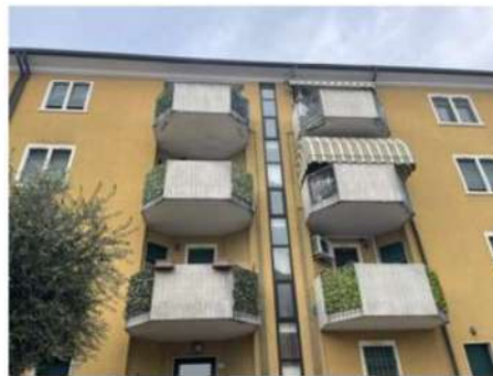
2 prospetto sud edificio principale
