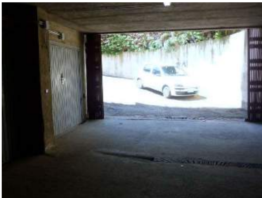
Figura 18 - GARAGE: ingresso carrabile
