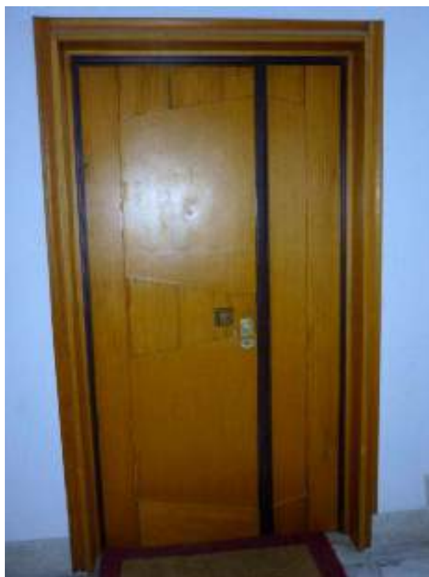
Figura 2 - APPARTAMENTO: Porta di Ingresso vista esterna
