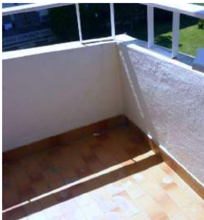
Figura 14 - APPARTAMENTO: particolare balcone e pavimentazione
