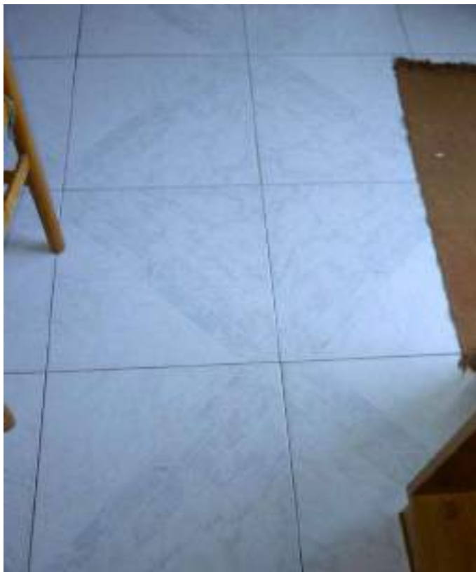
Figura 15 – APPARTAMENTO: particolare pavimentazione cucina
