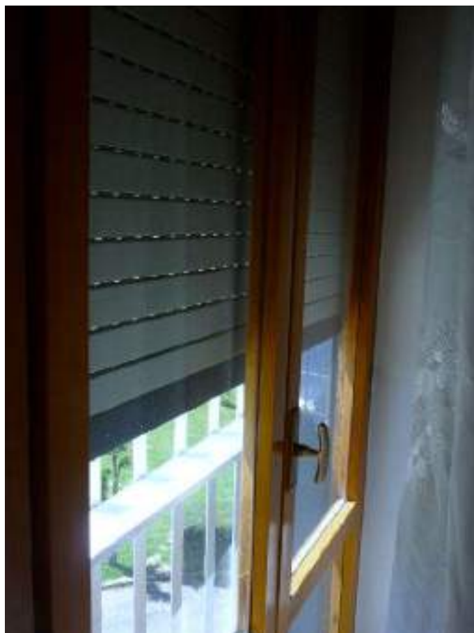
Figura 13 - APPARTAMENTO: Particolare infissi
