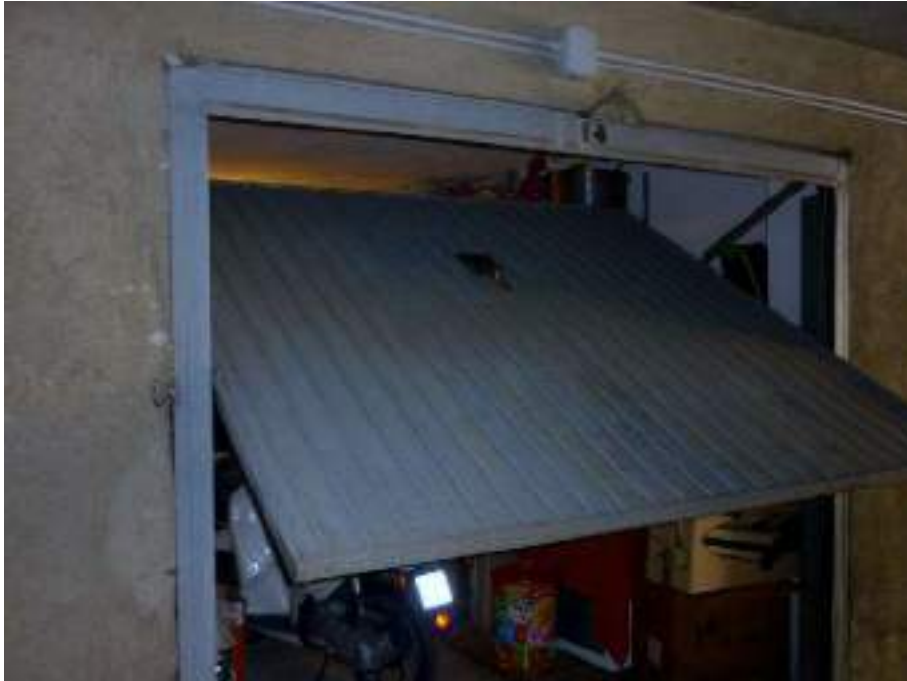
Figura 19 – GARAGE: ingresso porta garage basculante
