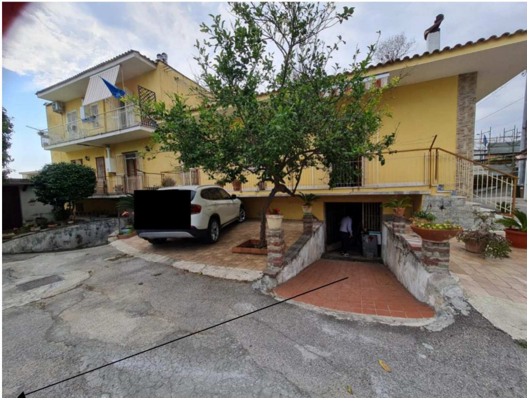
Rampa di accesso all'immobile subastato
