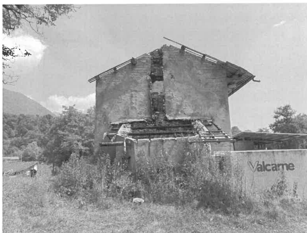
Foto 01: ex abitazione all'estremità Sud-Ovest (sub. 2)
