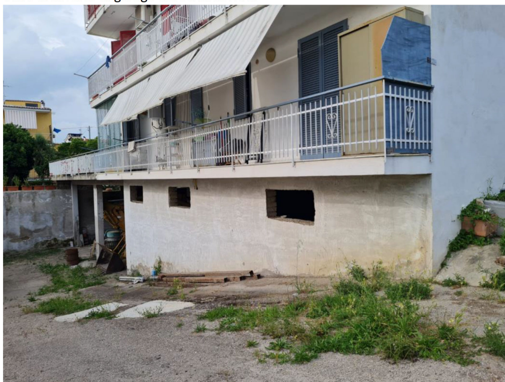
Rampa d'accesso al garage seminterrato
