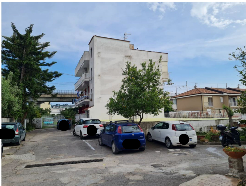
Viale di accesso al garage del seminterrato
