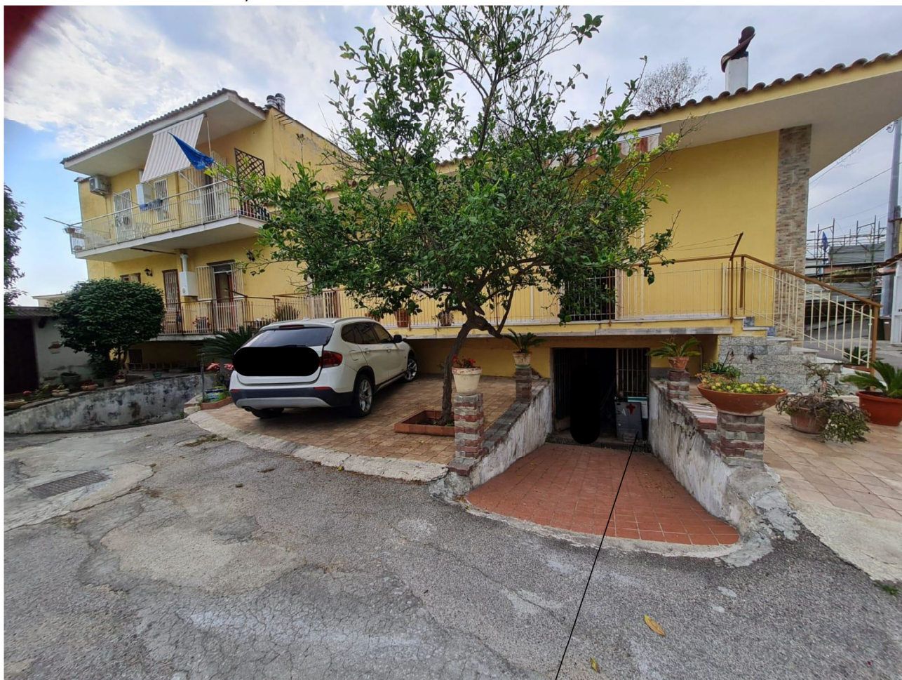
Fronte sud del civico 77, rampa d'accesso all'immobile subastato
