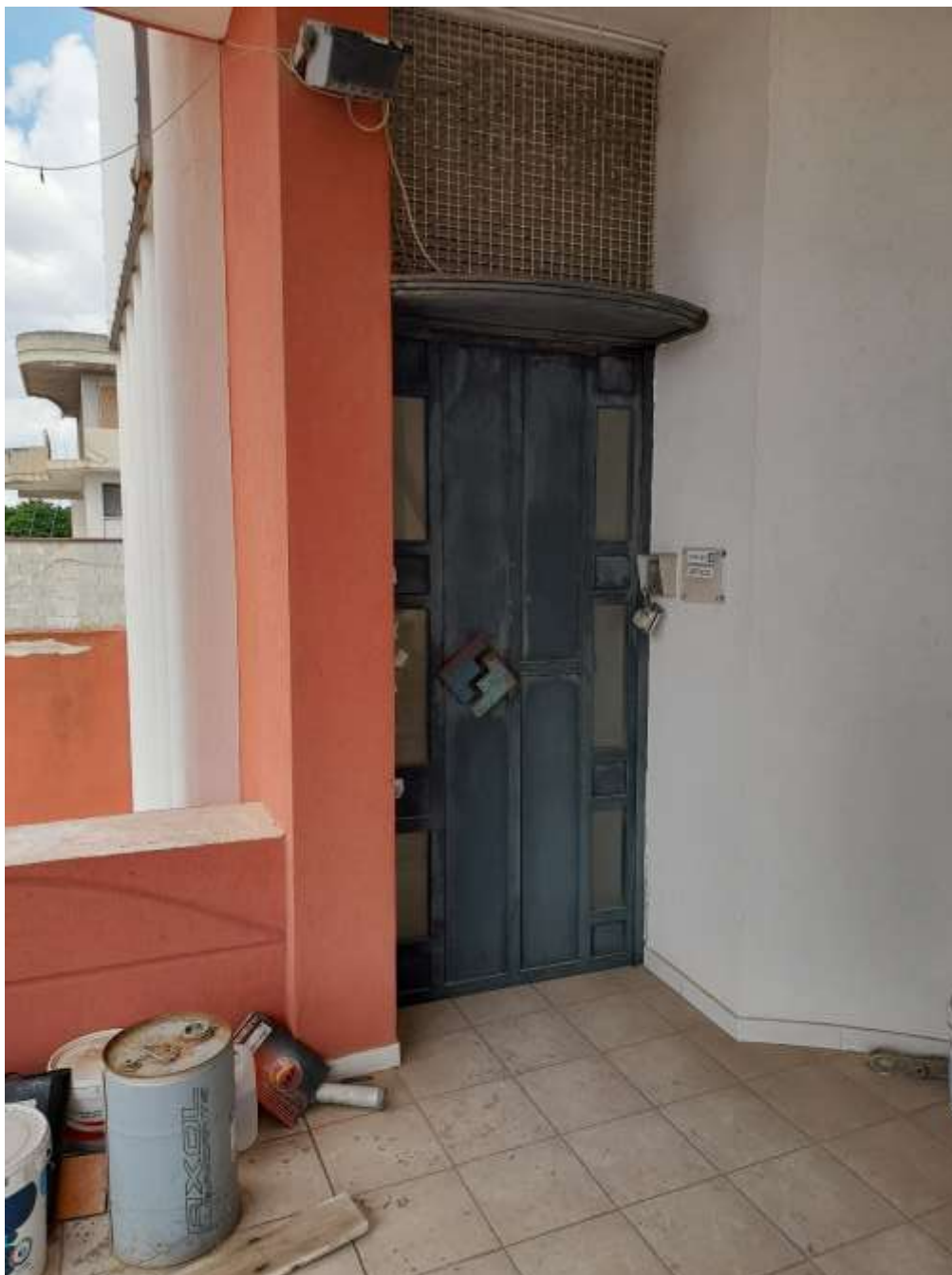
Foto n. 33 – INGRESSO PIANO 1 DALL'ESTERNO
