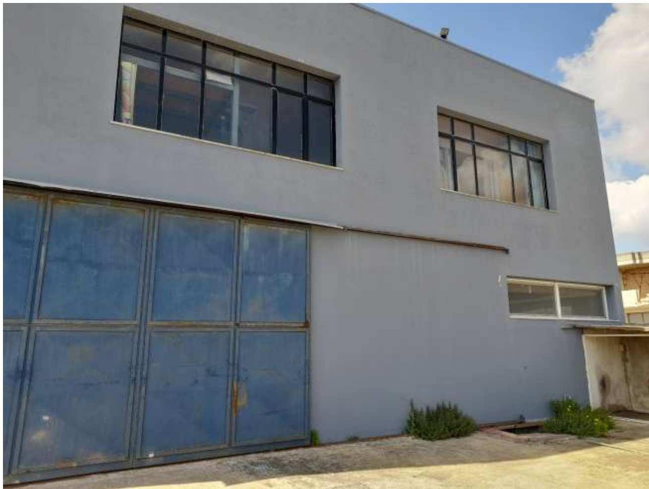
Foto n. 12 – INGRESSO LATO POSTERIORE
