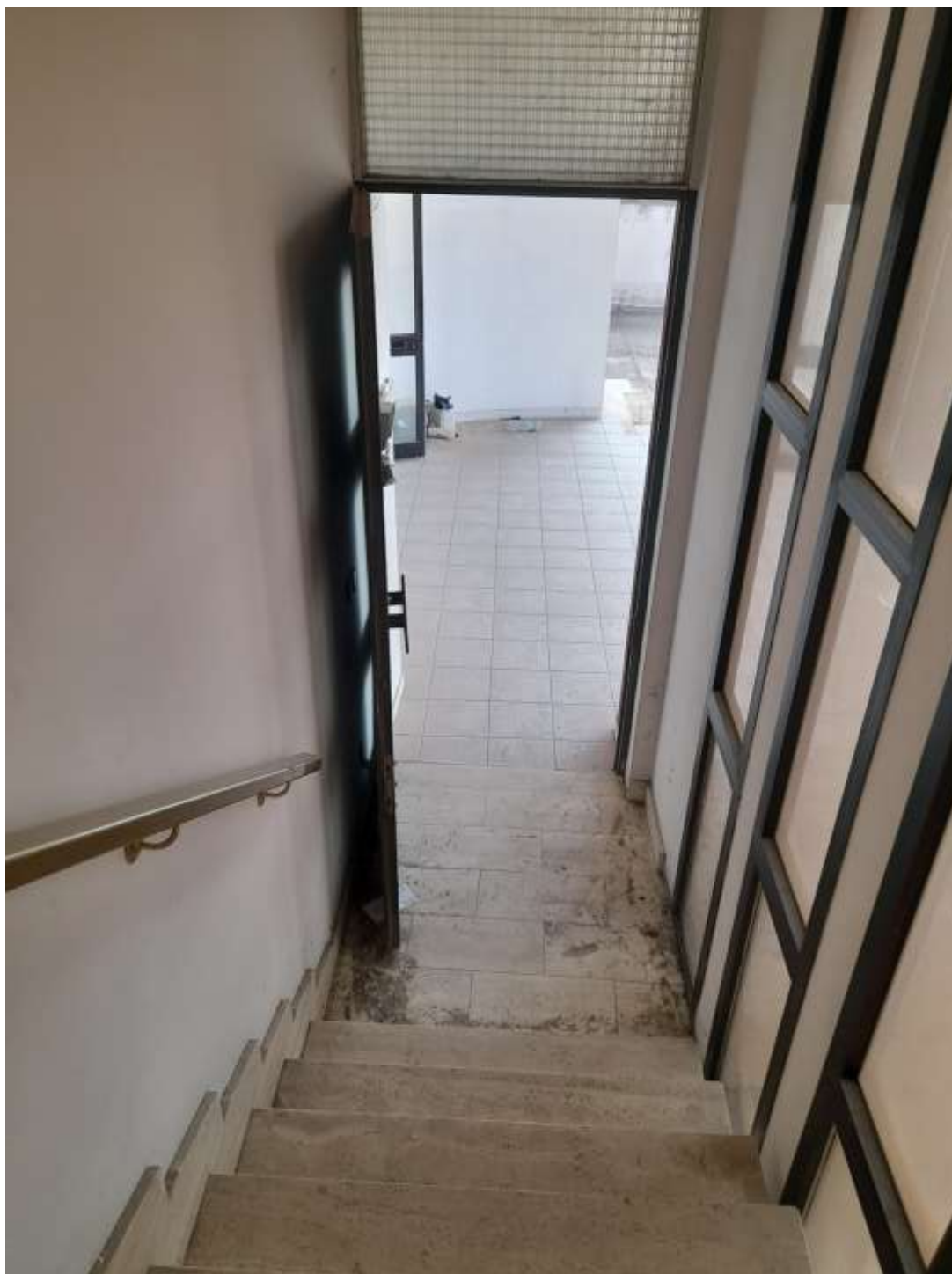
Foto n. 34 – SCALE INGRESSO PIANO 1
