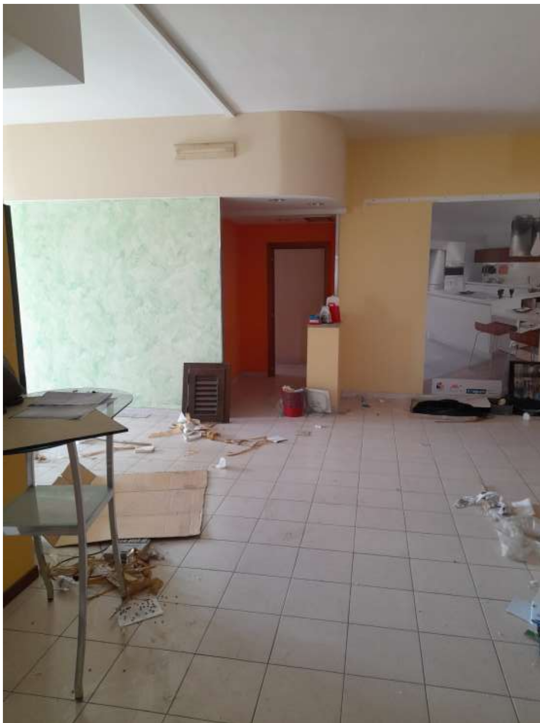
Foto n. 40 – INTERNO PIANO 1 - INGRESSO UFFICI
