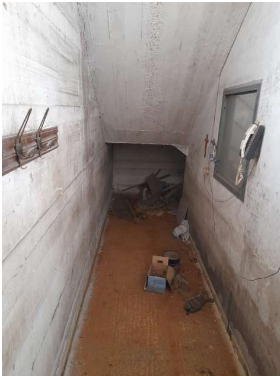
Foto n. 31 – INTERNO SOTTOSCALA PIANO -1
