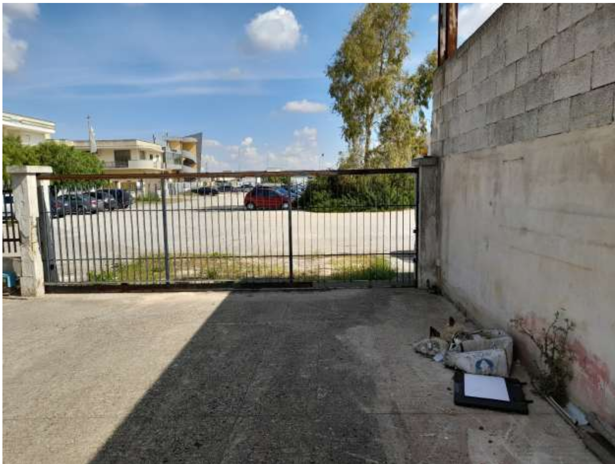
Foto n. 11 - 3 CANCELLO CARRABILE LATO POSTERIORE
