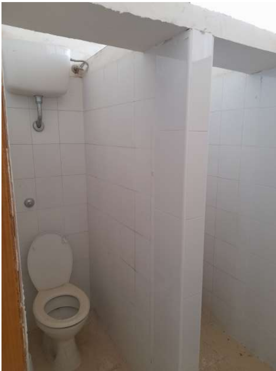
Foto n. 21 – PIANO TERRA – WC
