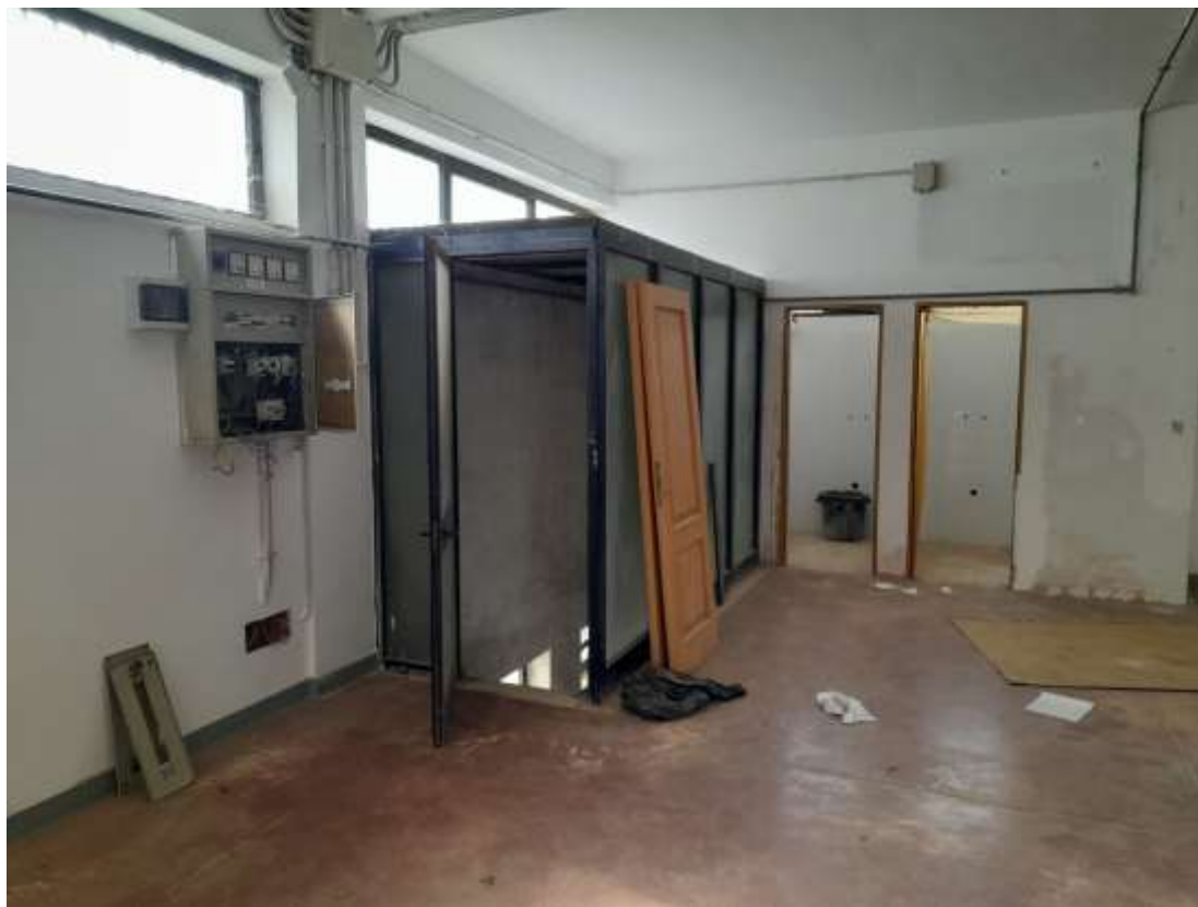
Foto n. 19 – PIANO TERRA – ACCESSO PIANO -1
