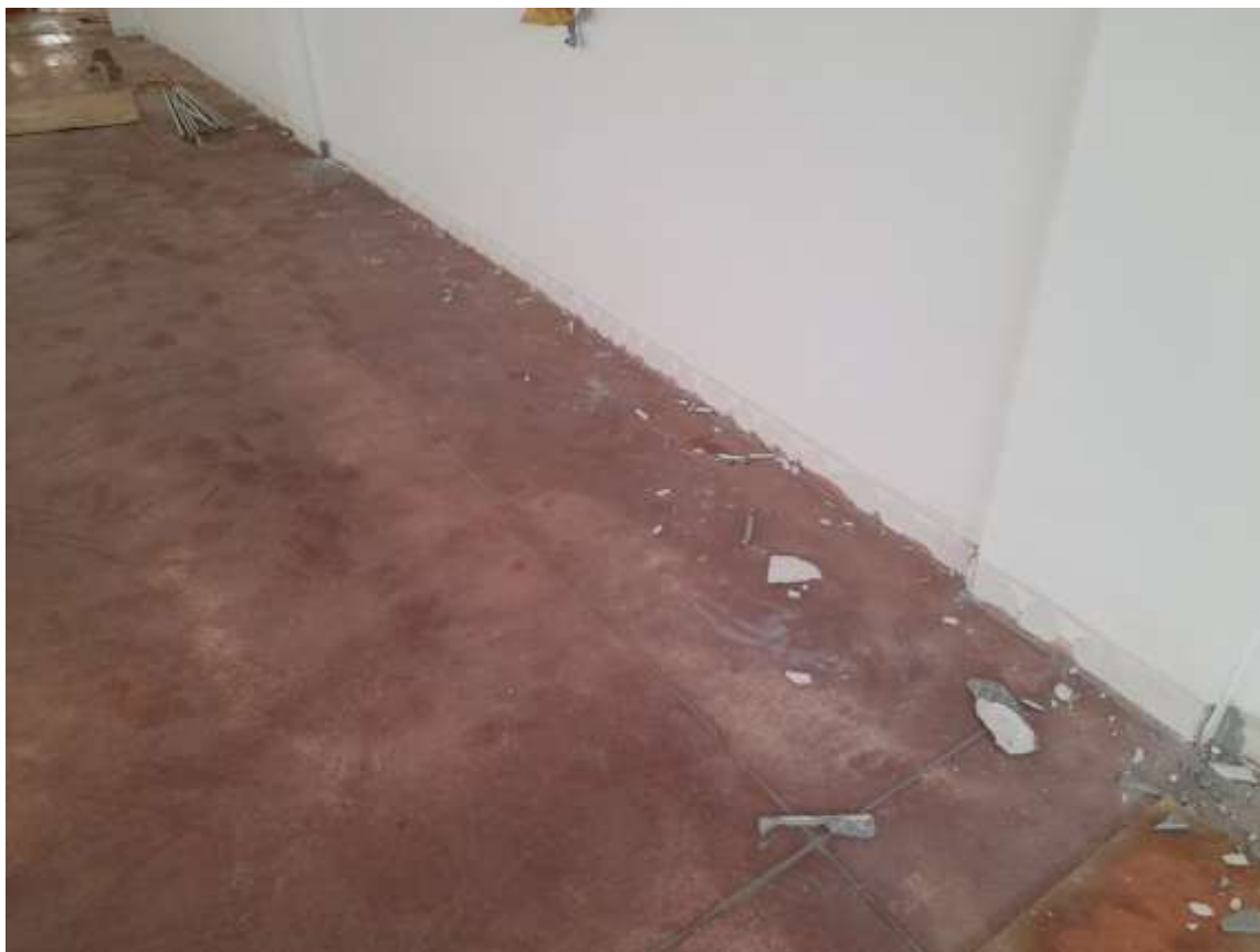
Foto n. 18 – PIANO TERRA - PAVIMENTAZIONE
