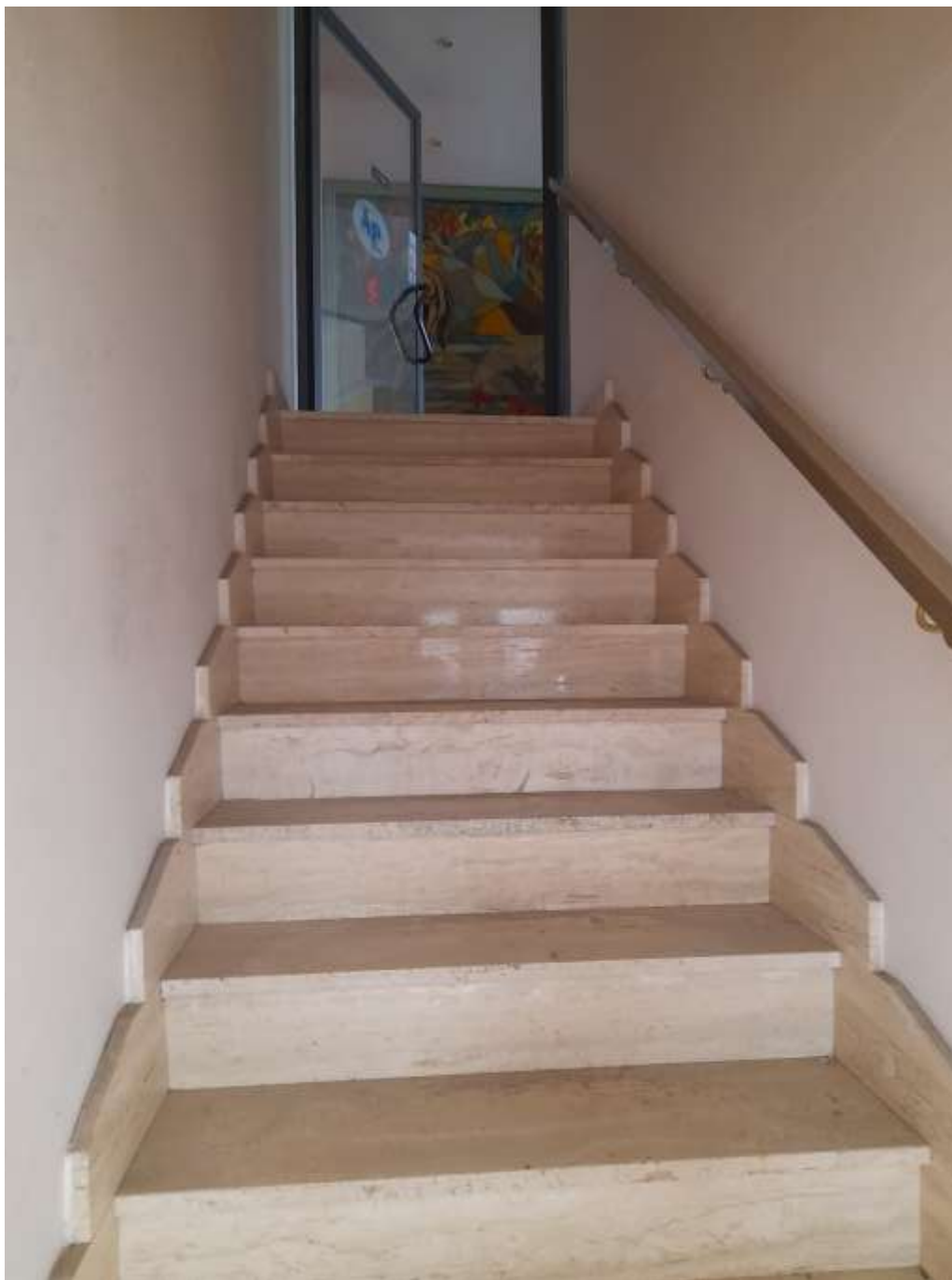
Foto n. 36 – SCALE INGRESSO PIANO 1
