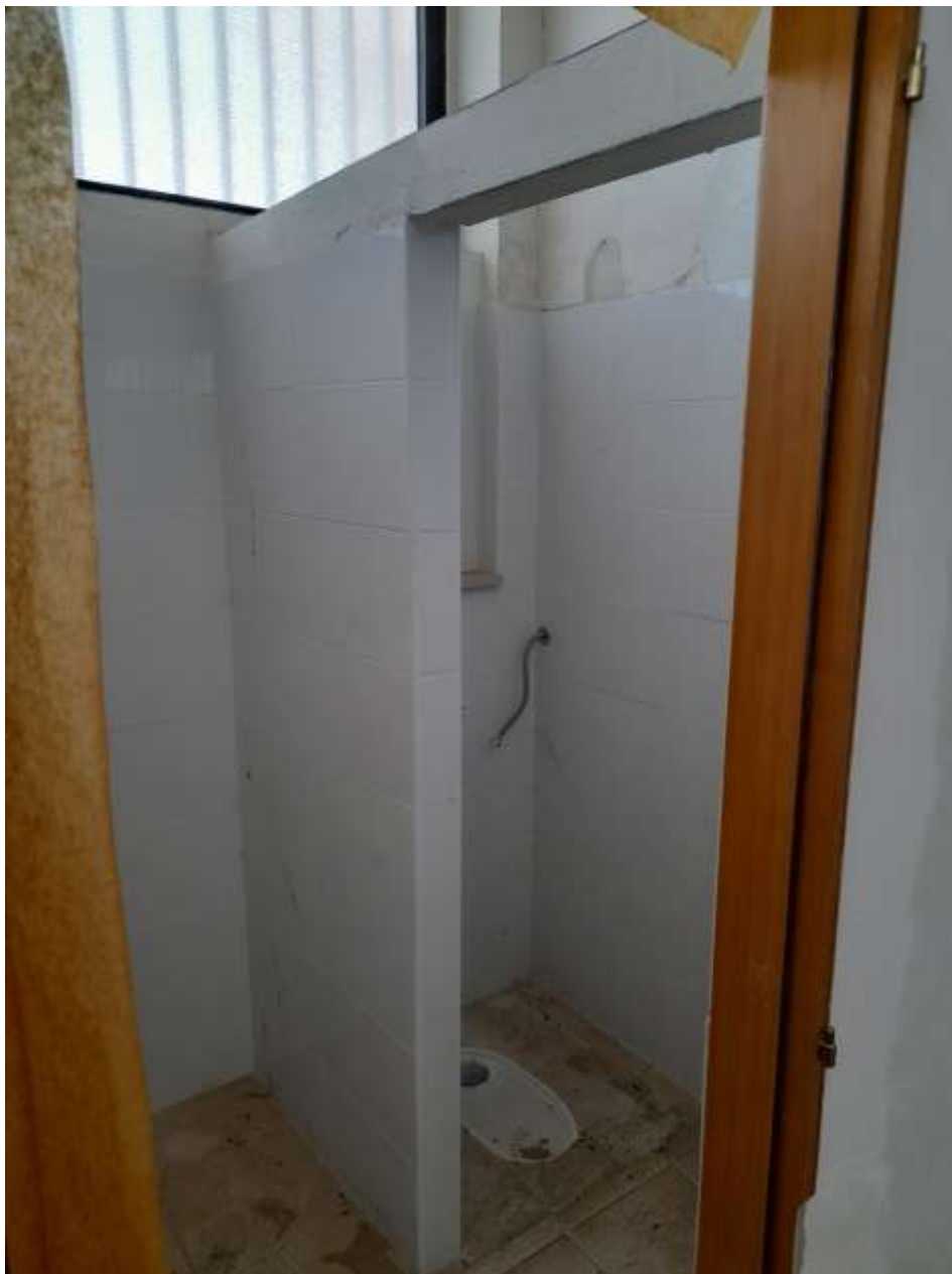
Foto n. 20 – PIANO TERRA – WC
