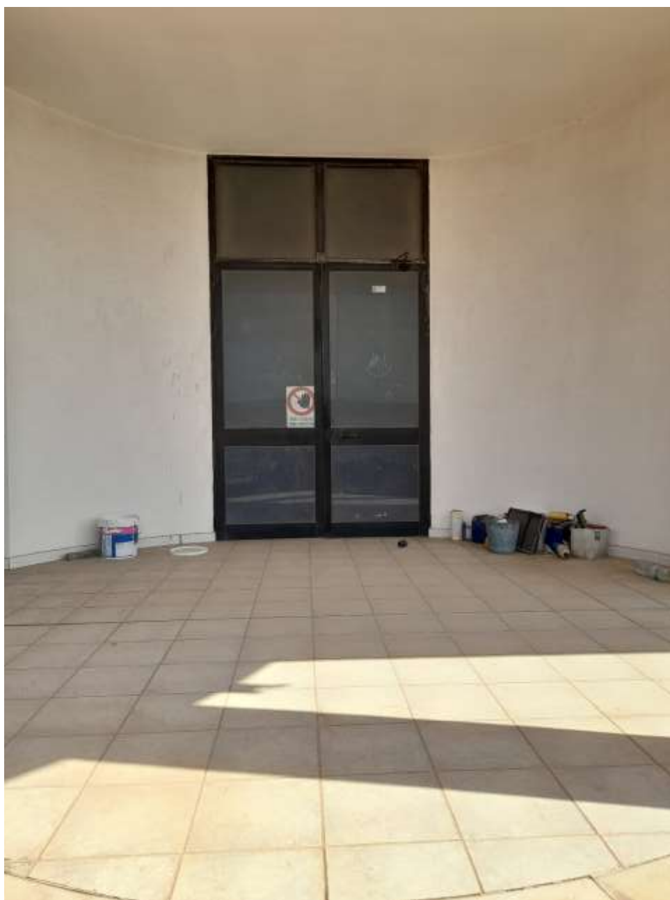
Foto n. 15 – INGRESSO PIANO TERRA
