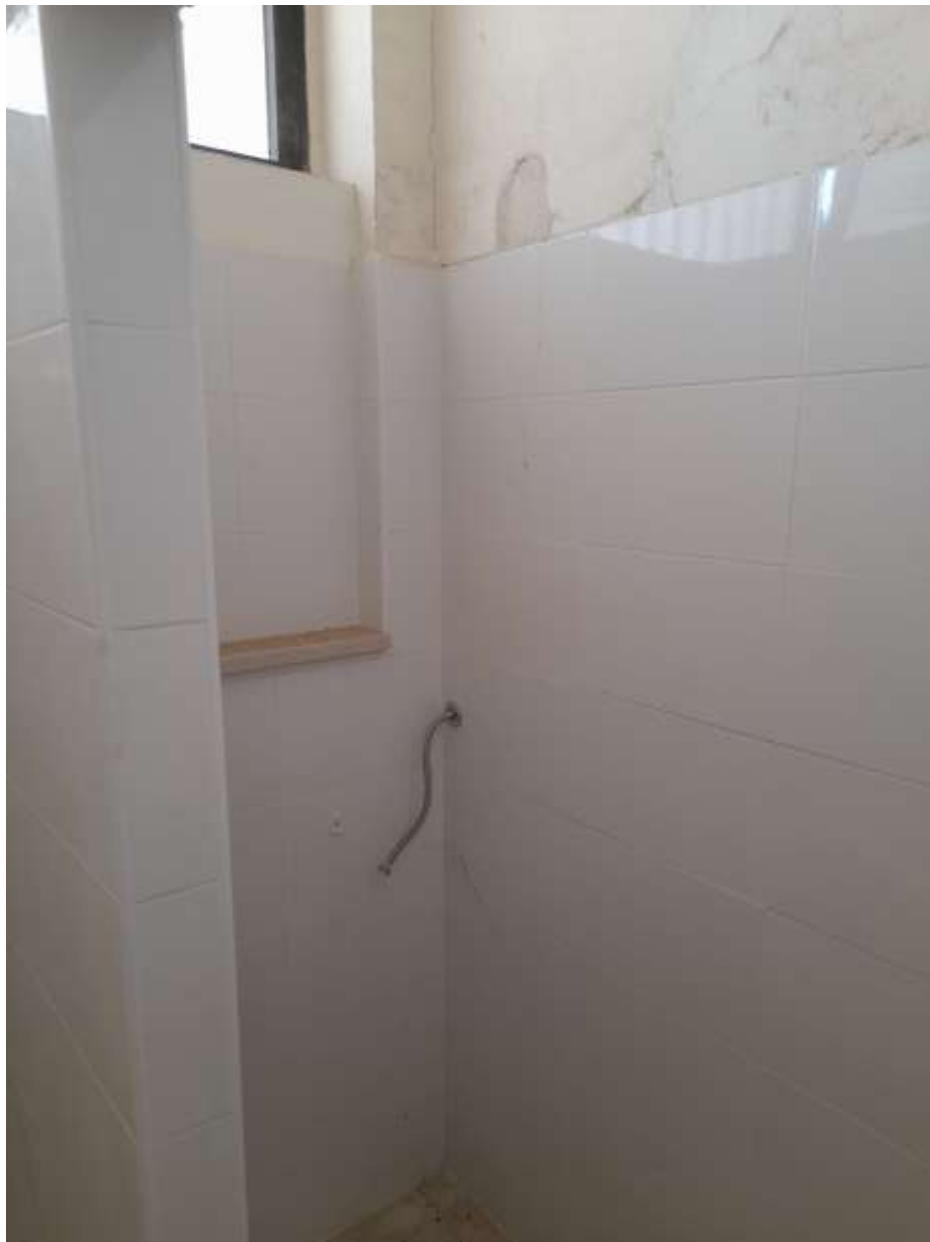
Foto n. 23 – PIANO TERRA – WC
