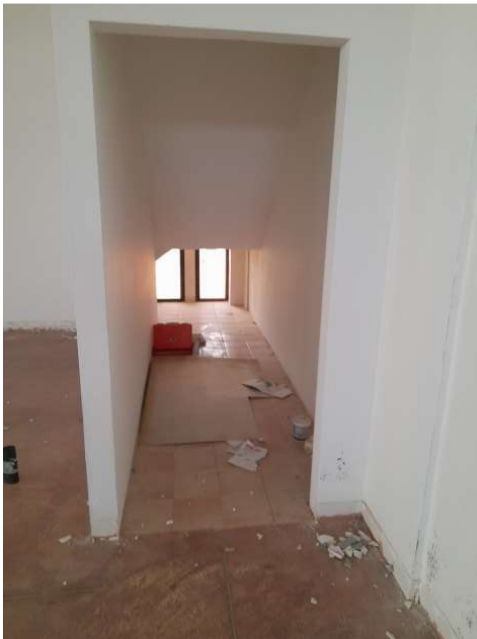
Foto n. 25 – PIANO TERRA – SOTTOSCALA
