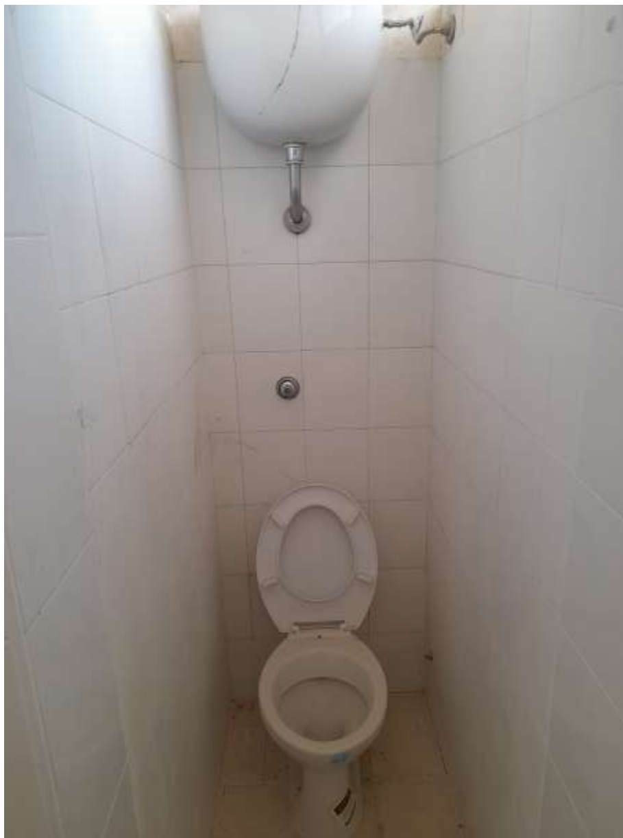
Foto n. 22 – PIANO TERRA – WC
