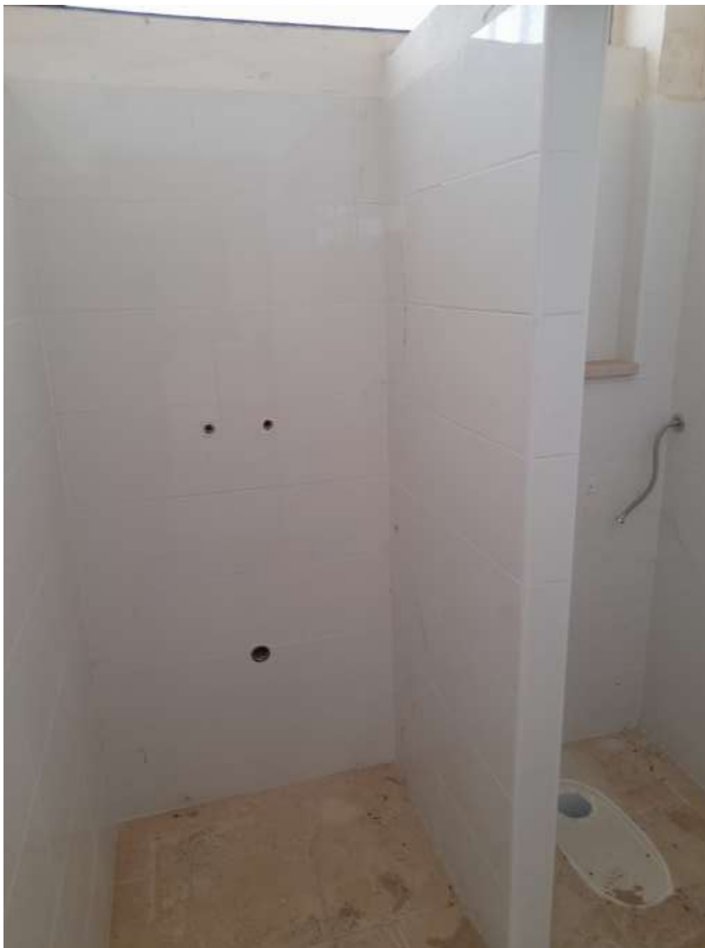
Foto n. 24 – PIANO TERRA – WC
