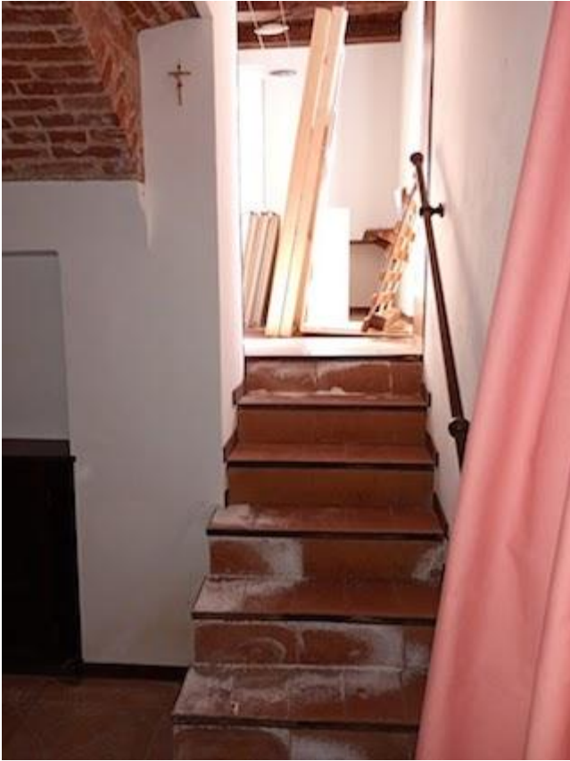
Scala accesso al sotterraneo
