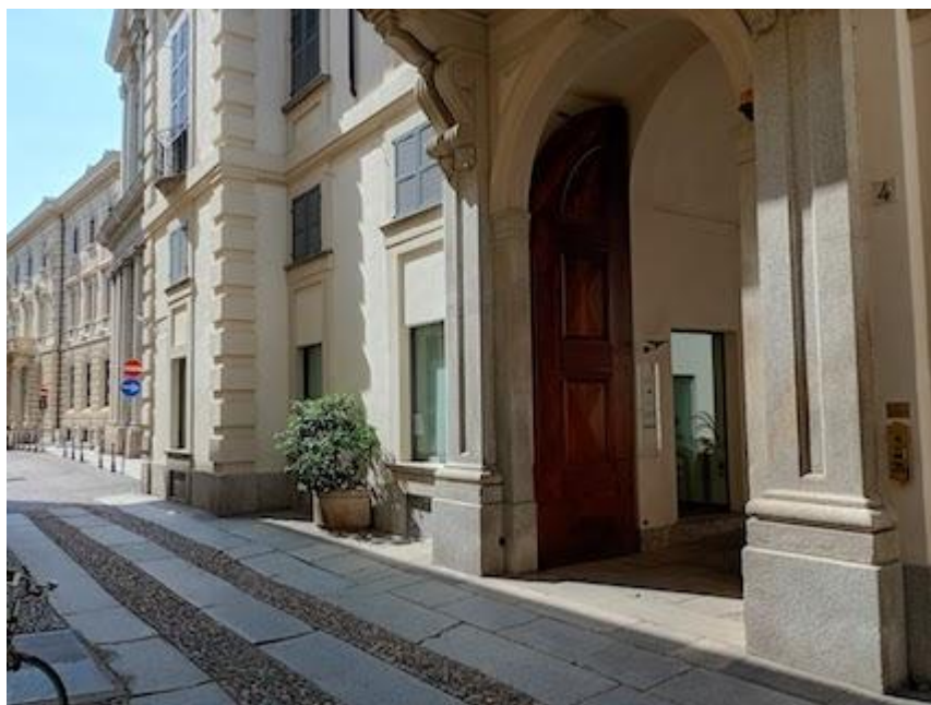
Vista esterna da Via Negrone
