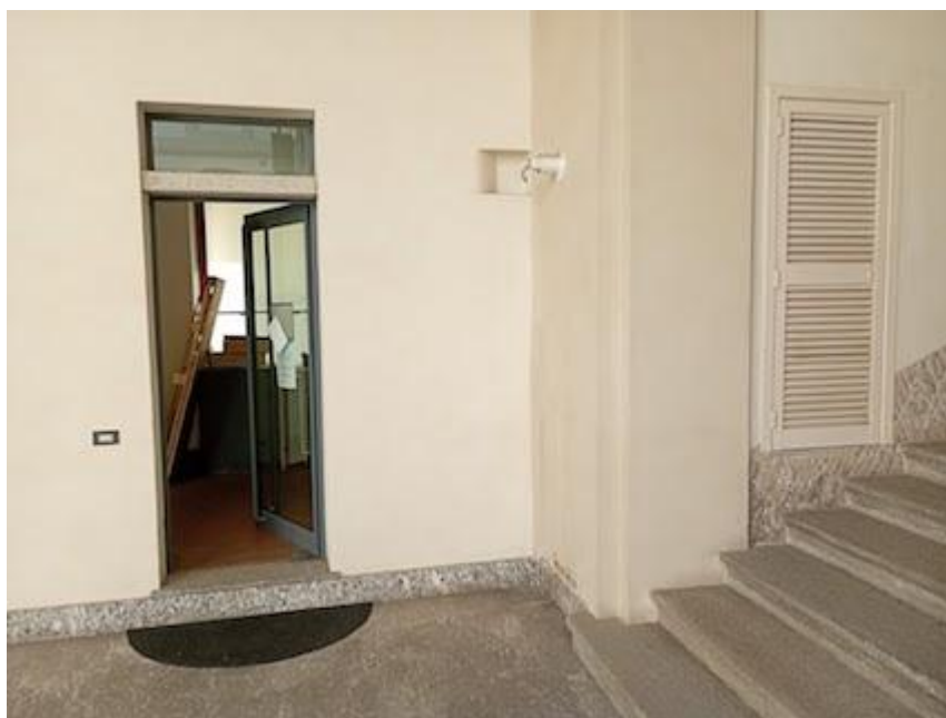
Ingresso locale da cortile interno
