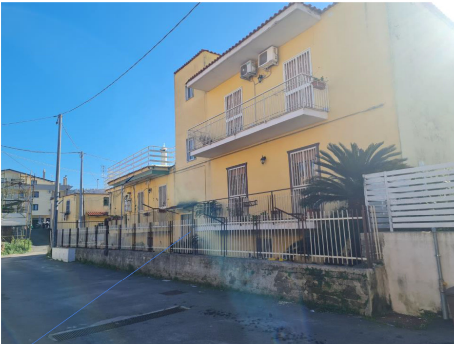
Portoncino di accesso al fabbricato
