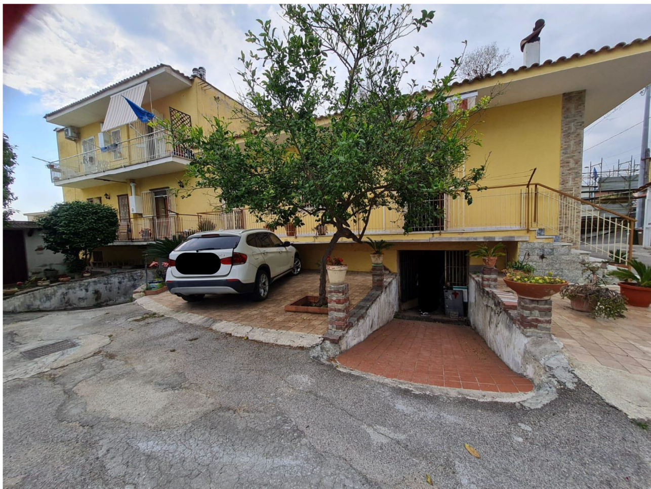
Fronte sud del fabbricato di cui è parte l'immobile de quo
