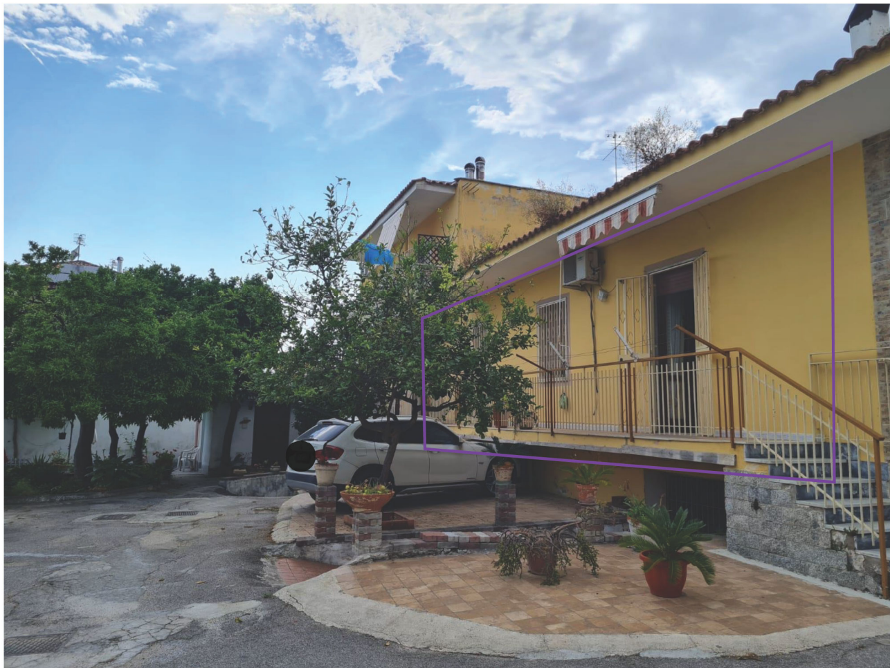
Fronte sud balcone (T1)
