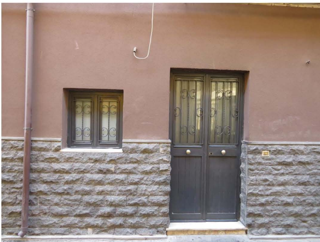
Foto 19 – Ingresso immobile via Mongiovi 20
