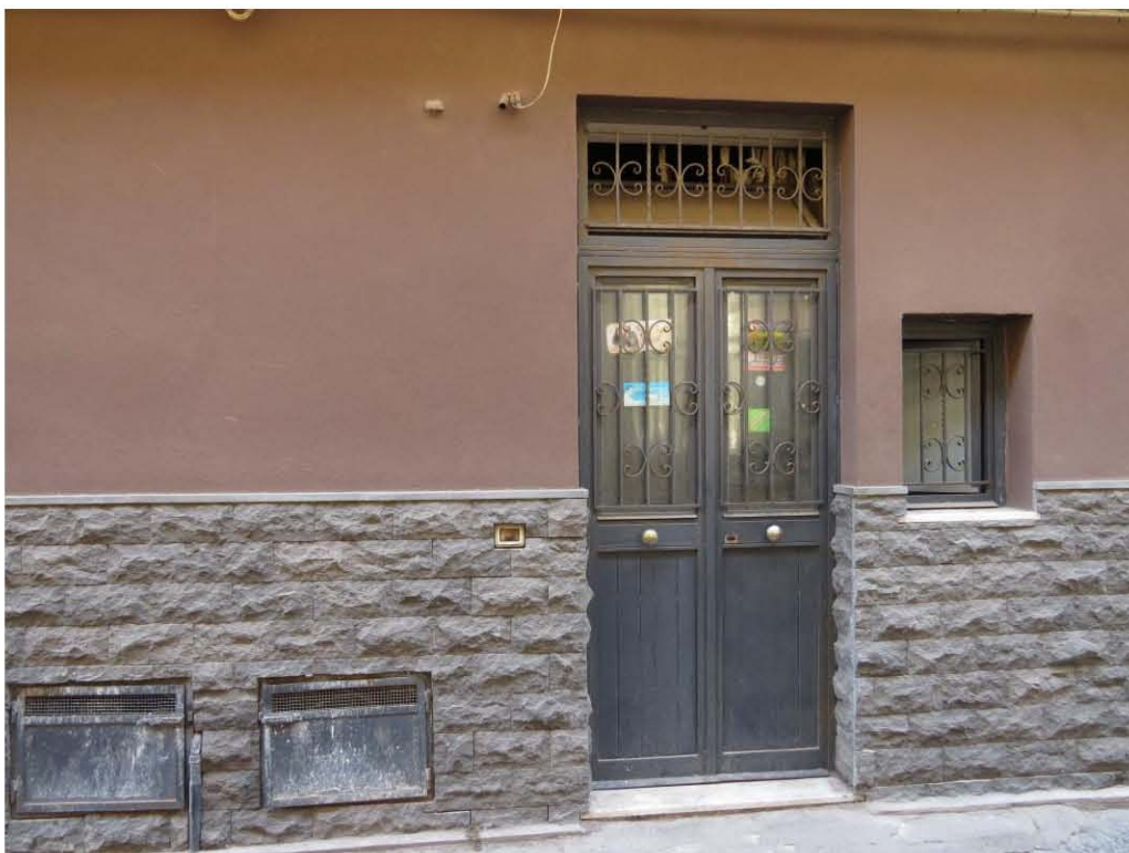
Foto 15 – Ingresso immobile via Mongiovi 18
