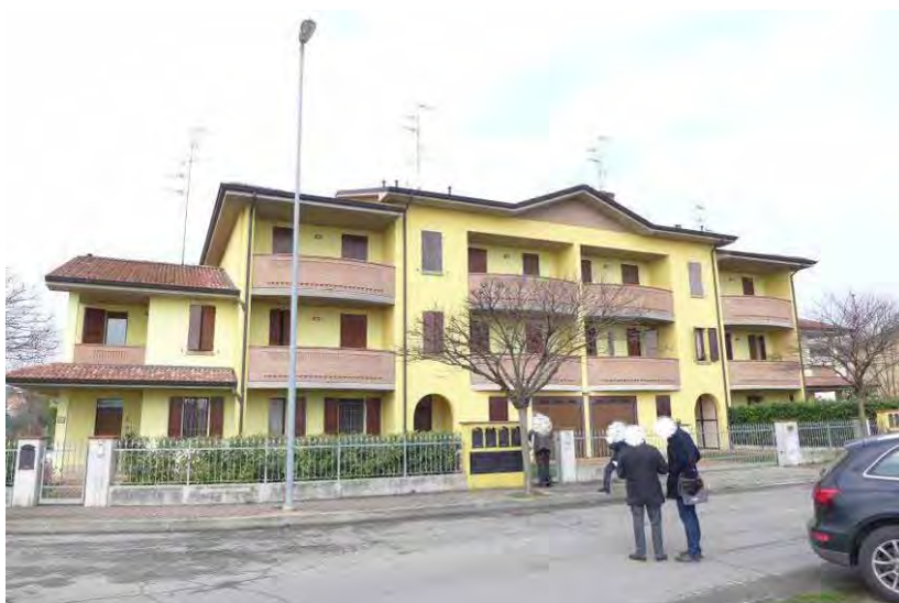
Figura 2: vista esterna immobile lato est
