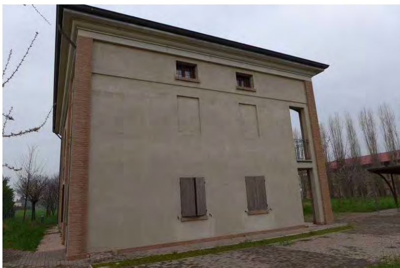
Figura 5: vista esterna lato nord.
