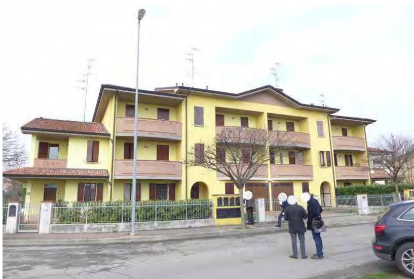
Figura 2: vista esterna immobile lato est
