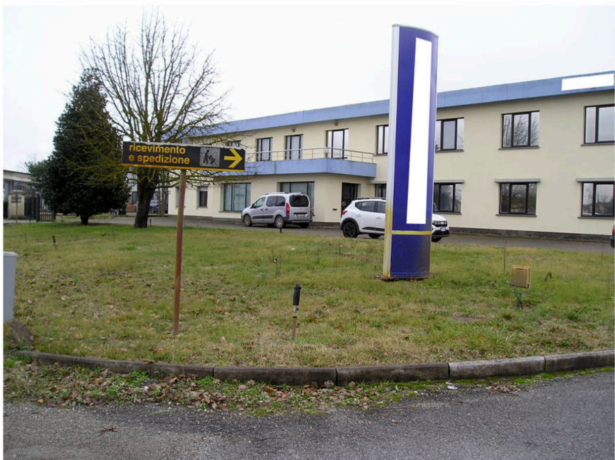
Fotografia 02 - Esterni / Fronte Edificio
