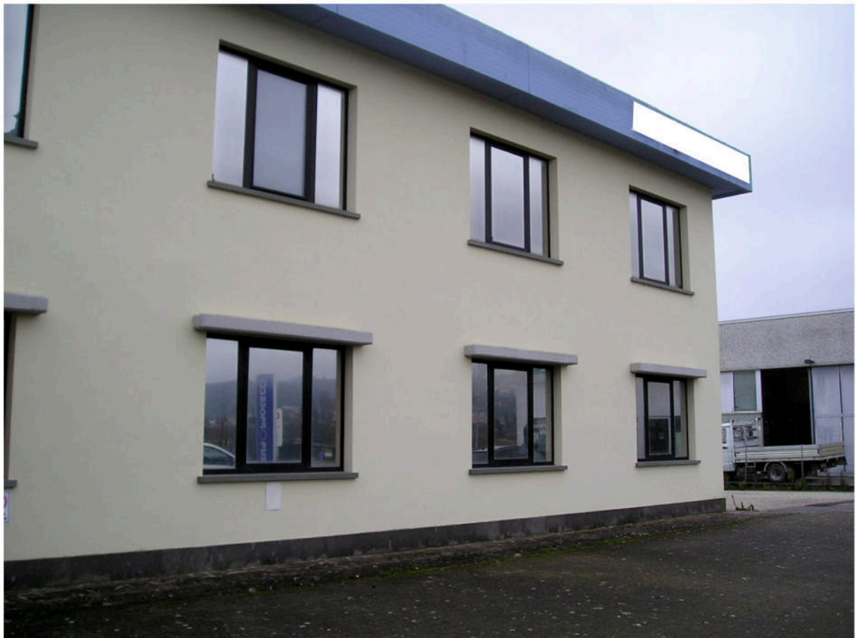
Fotografia 04 - Esterni / Fronte Edificio
