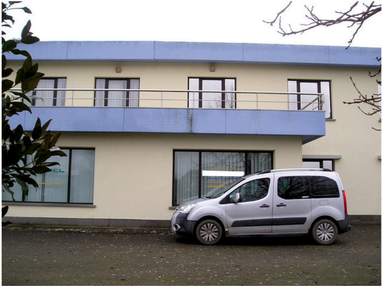
Fotografia 03 - Esterni / Fronte Edificio
