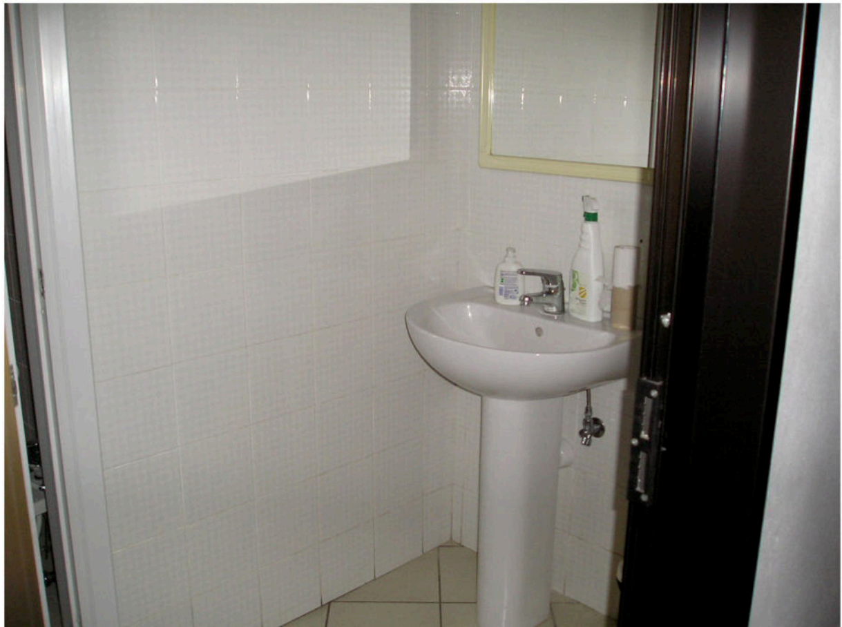
Fotografia 18 - Interni / Uffici P.T. - Servizi Igienici
