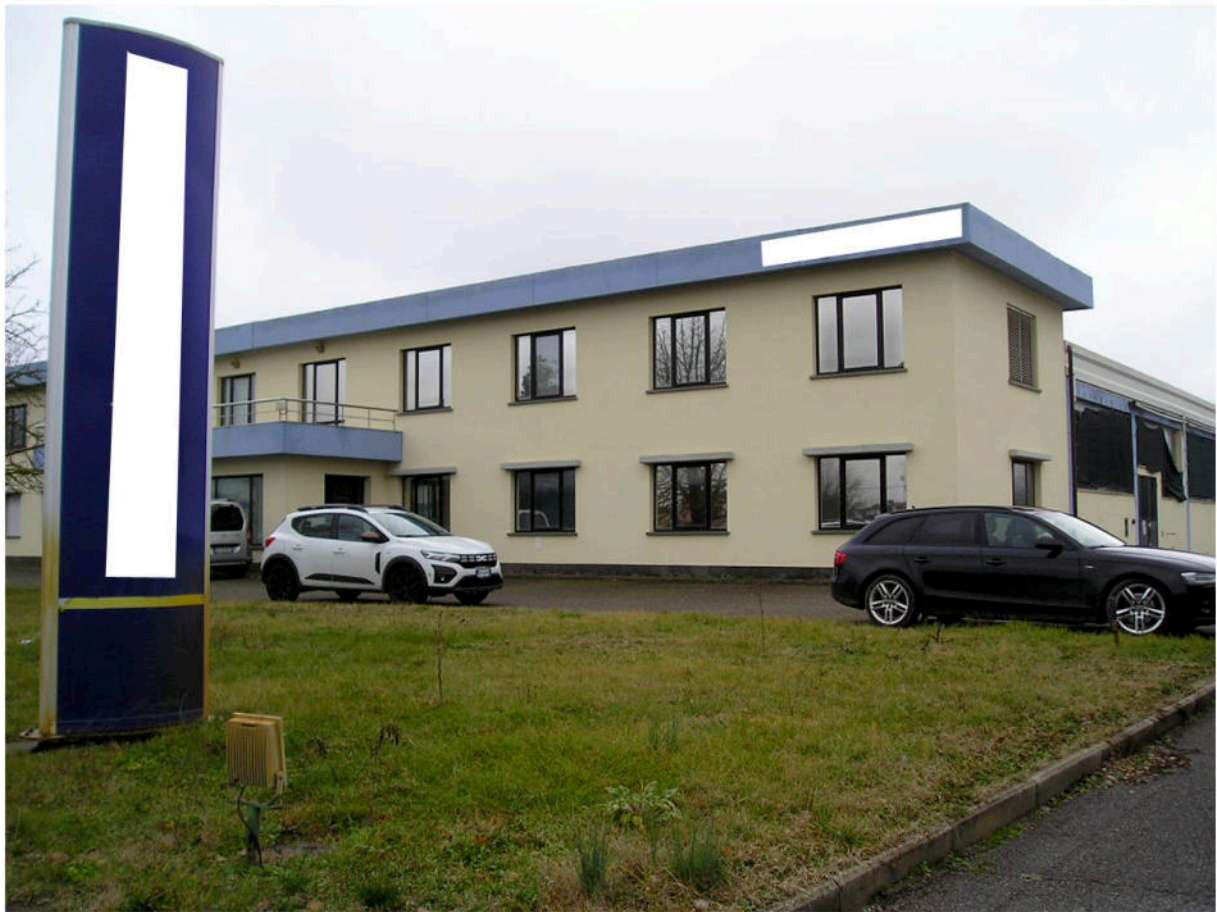
Fotografia 01 - Esterni / Fronte Edificio
