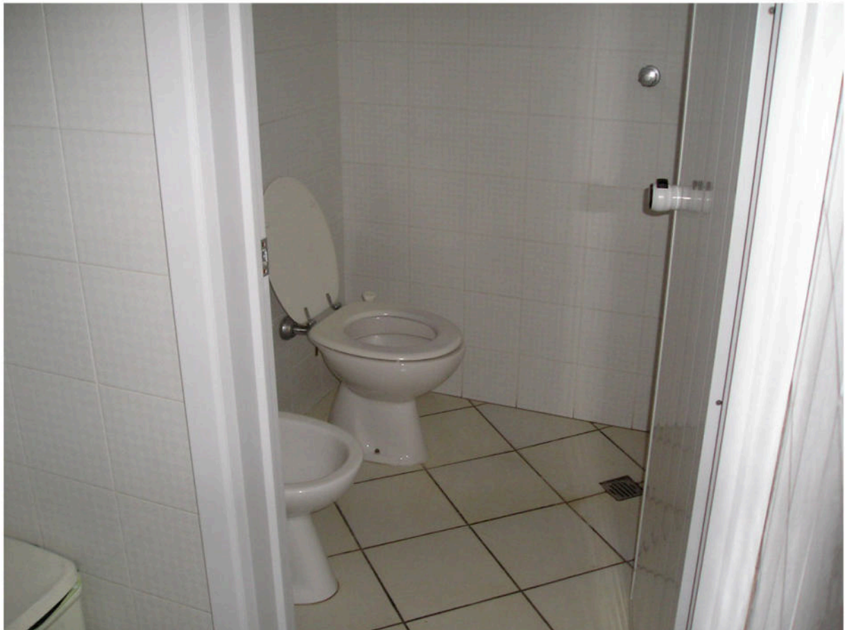
Fotografia 24 - Interni / Uffici P.1 - Servizi Igienici
