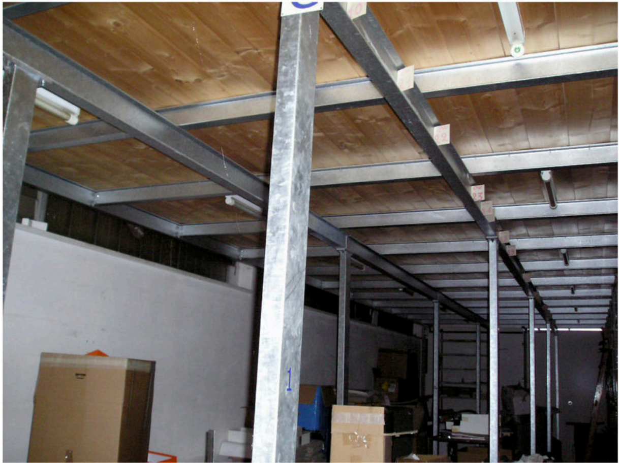
Fotografia 27 - Interni / Scaffalatura - Soppalco
