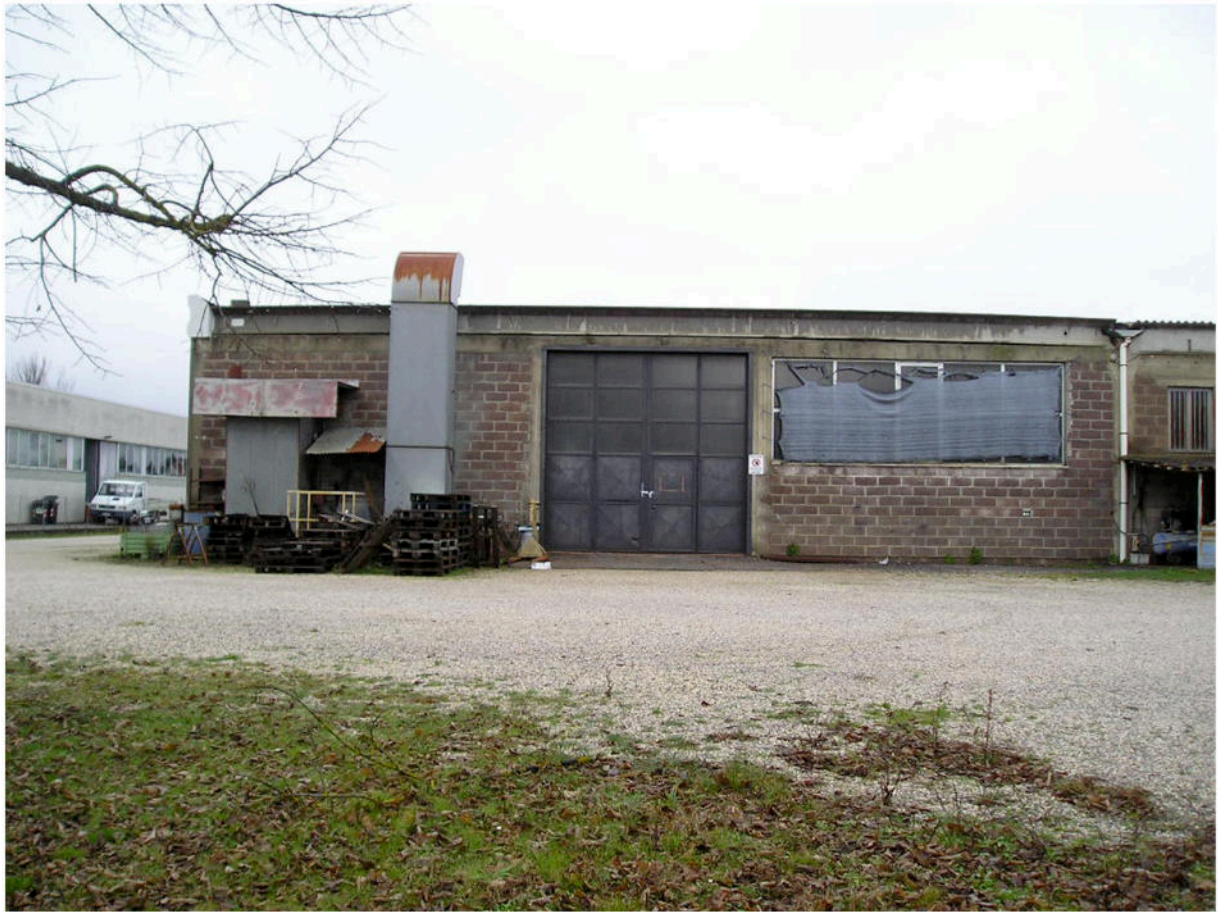
Fotografia 07 - Esterni / Retro Edificio
