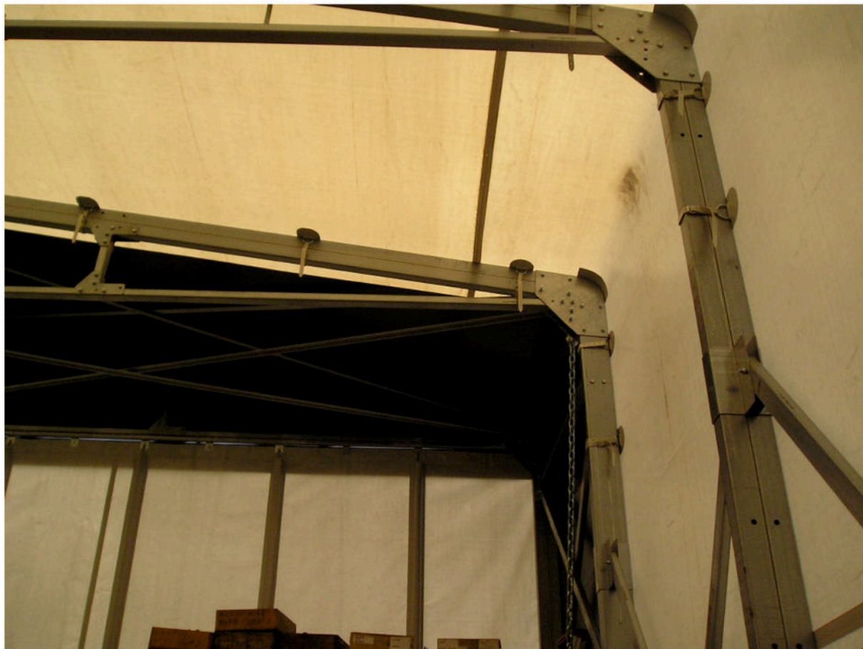
Fotografia 33 - Interno Struttura Telonata
