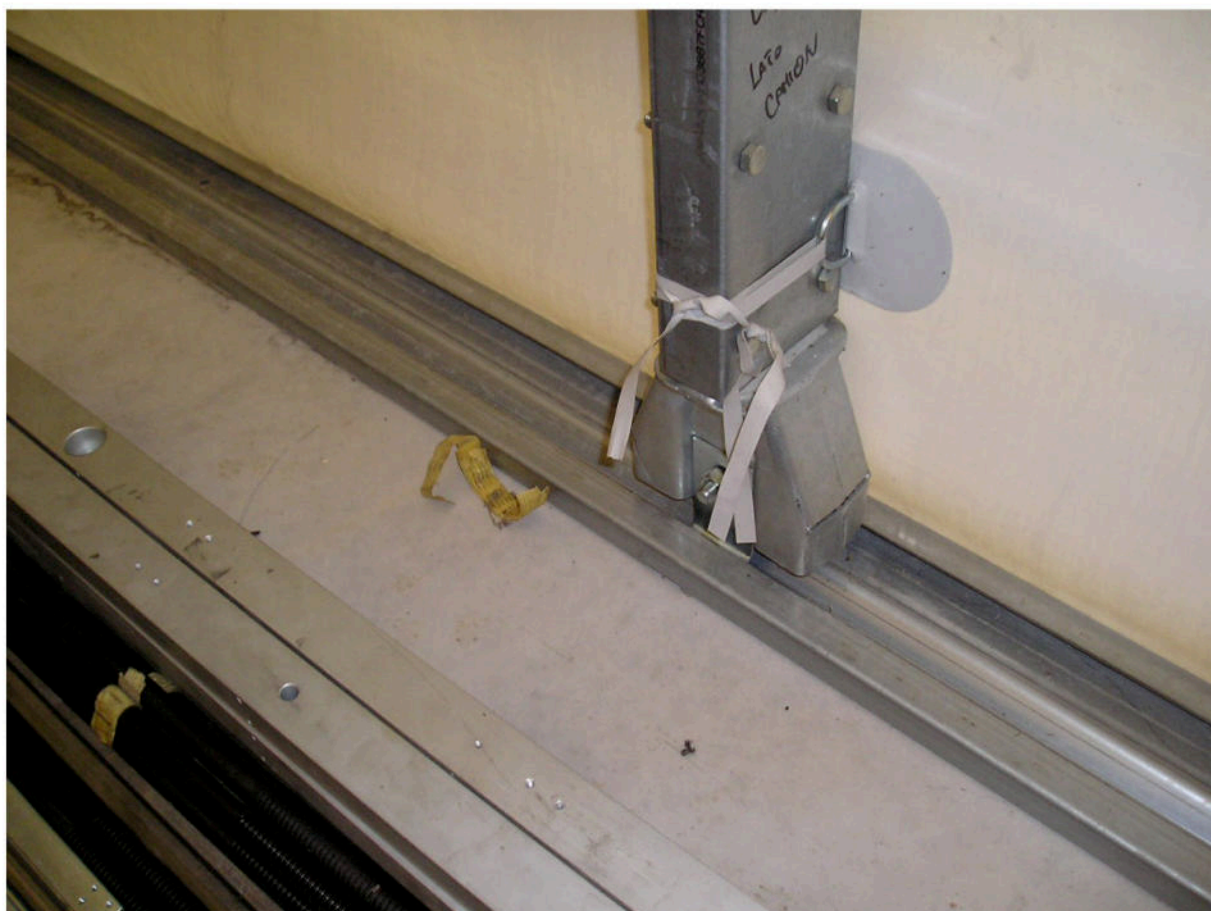
Fotografia 34 - Interno Struttura Telonata
