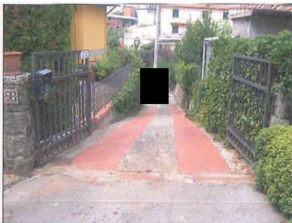
Fotografia 29: Bene 3 – Rampa d'ingresso dalla via
