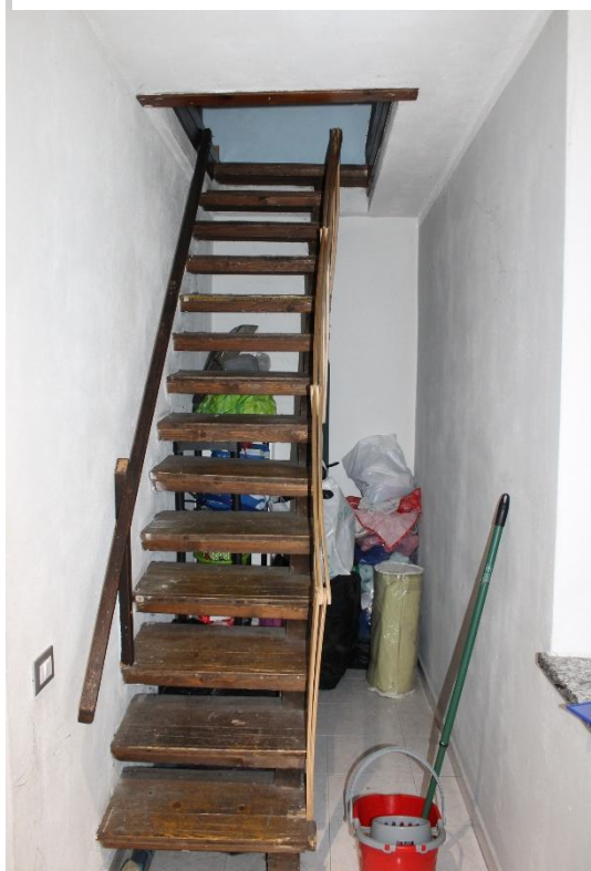
Viste interne sottotetto e relativo accesso
