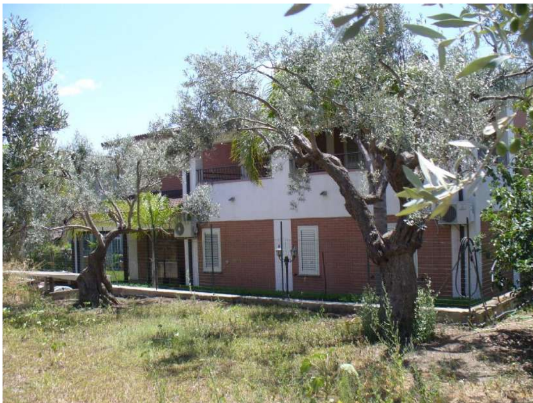
FOTO N. 2 – Prospetto lato opposto a via Fossecalì –
