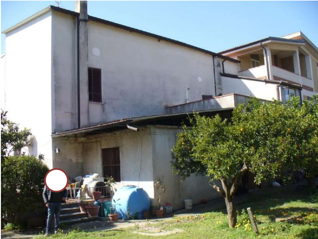
FOTO N. 9 -prospetto lato opposto a via Fossecalì-
