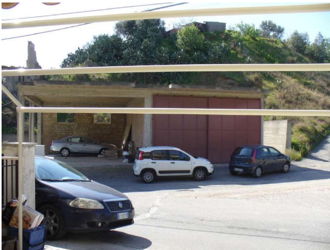
FOTO N. 18 – fabbricato in corso di costruzione fg 10 part. 5 -
