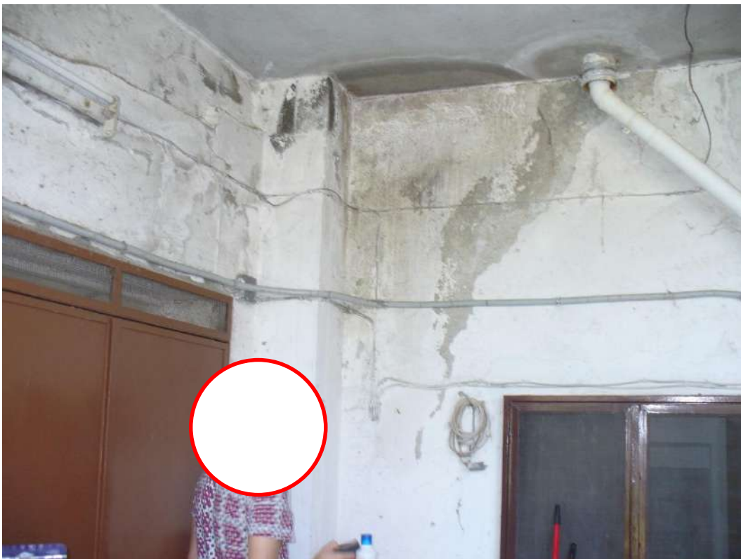
FOTO N. 16 – locale di sgombero-
