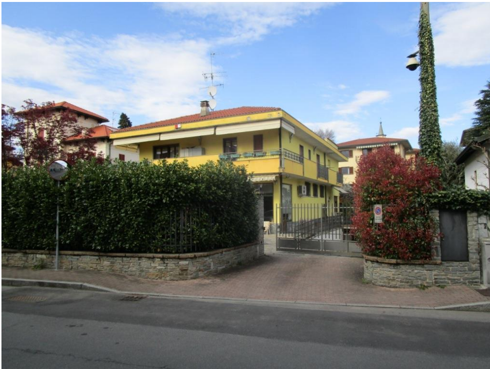
Foto 1 – Vista da via Bertolotti del fabbricato residenziale in esame
