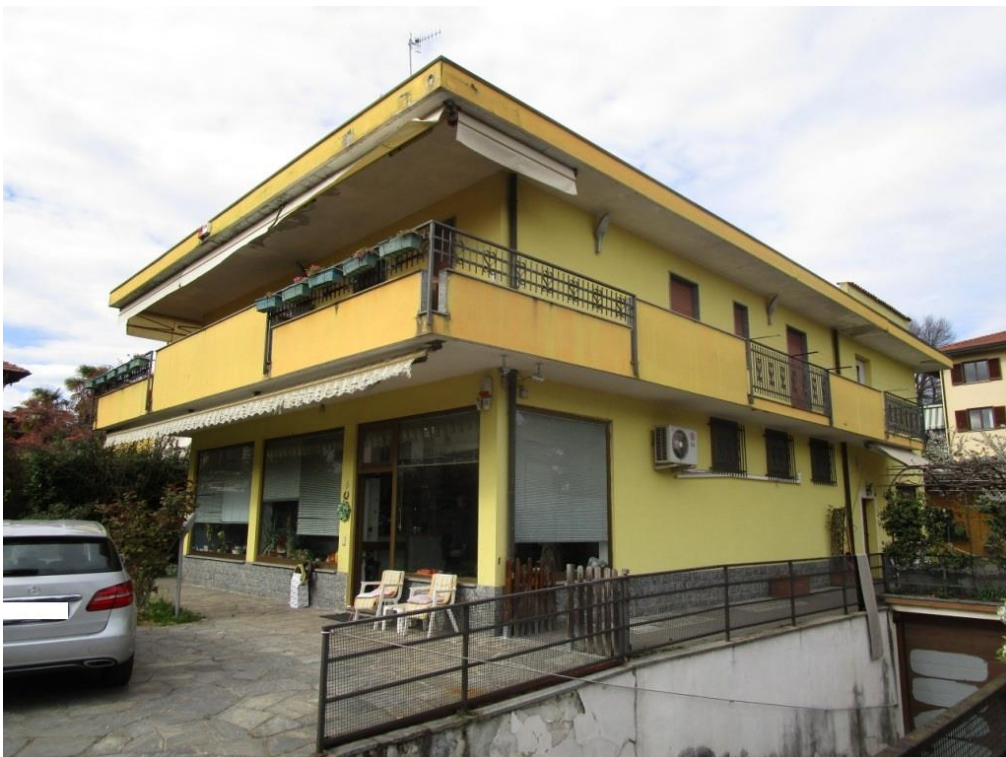
Foto 2 – Vista dall'edificio dal cortile interno
