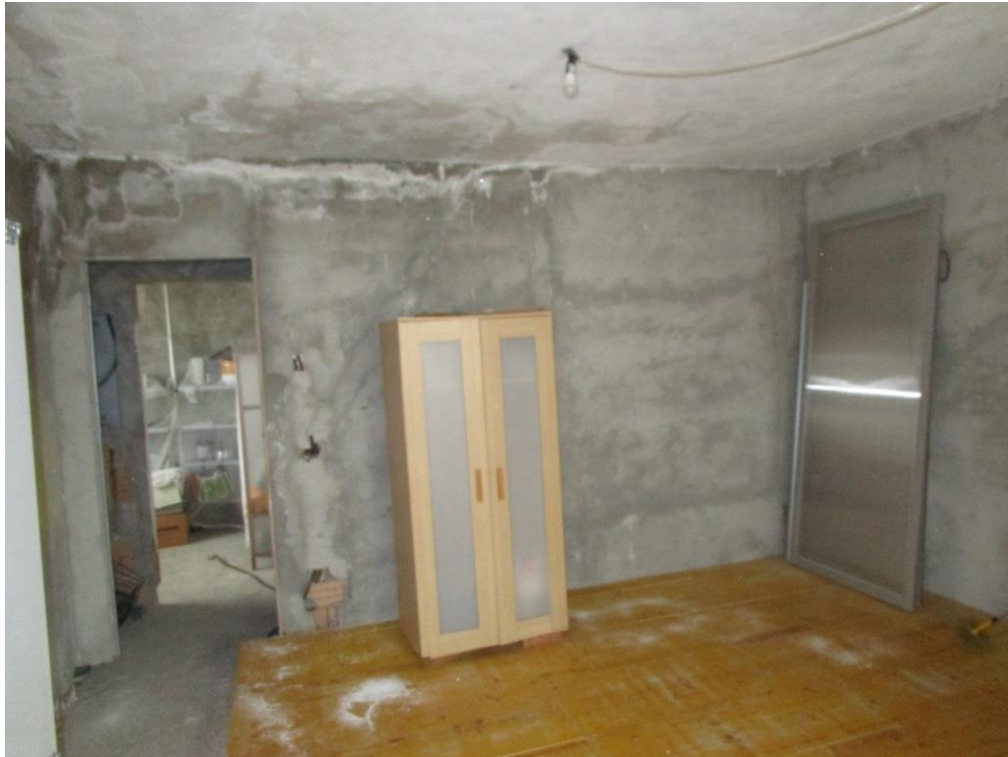
Foto 36 – Porzione di appartamento al piano primo con presenza di infiltrazioni
