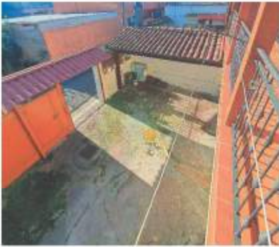
Immagine n.6: Vista tettoia e cortile lato Ovest
