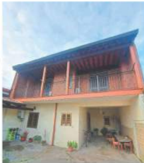
Immagine n.5: Vista da cortile interno
