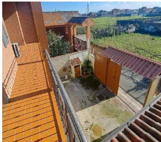
Vista cortile lato Est
