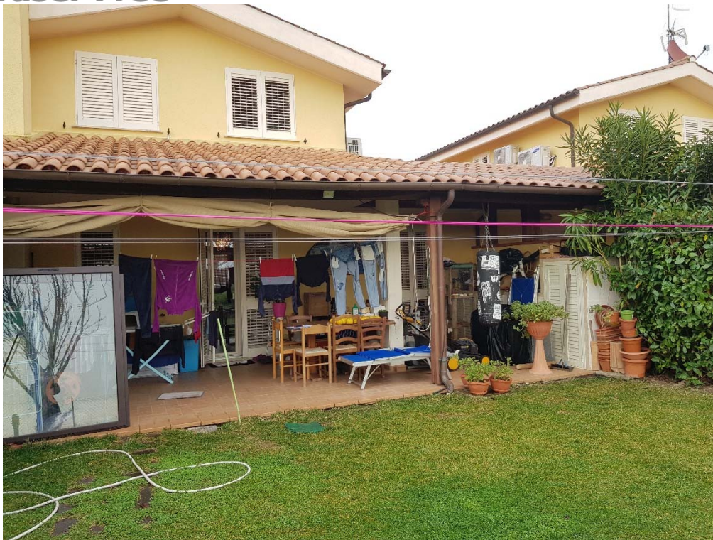
FOTO 3 – Vista porticato e corte esclusiva
