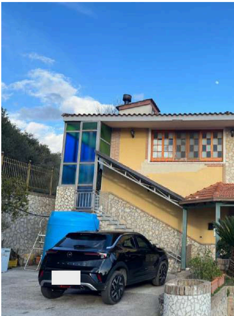
Foto n. 10 - Vista prospetto ovest corpo scala
