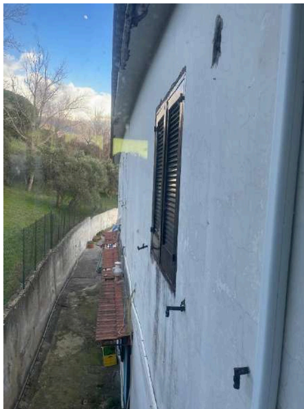
Foto n. 12 - Vista prospetto nord
