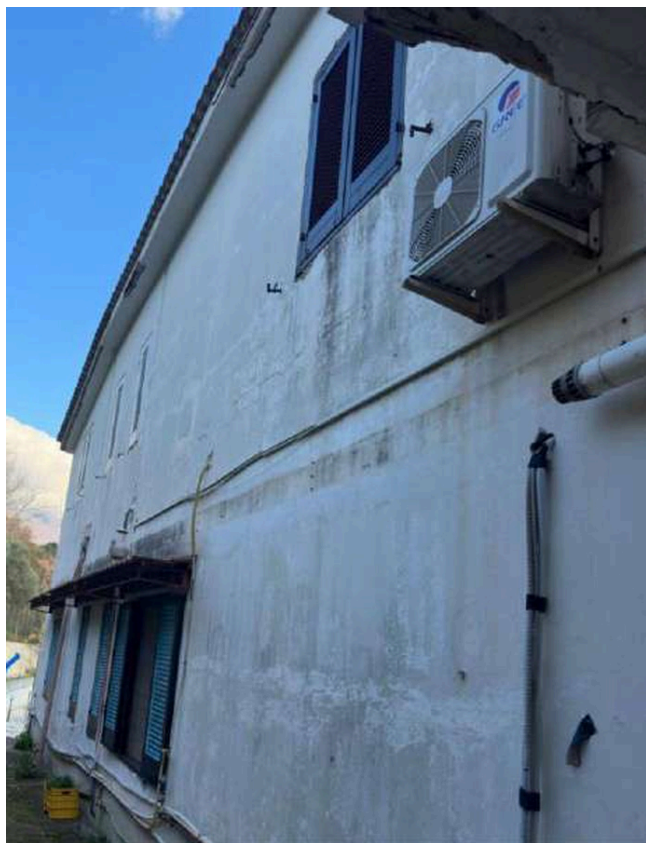
Foto n. 9 - Vista prospetto nord
