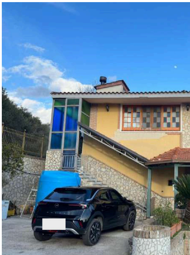
Foto n. 10 - Vista prospetto ovest corpo scala
