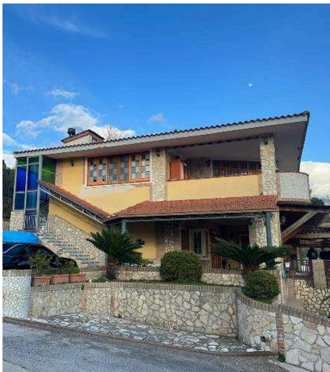
Foto n. 1 - Vista prospetto ovest lato ingresso
