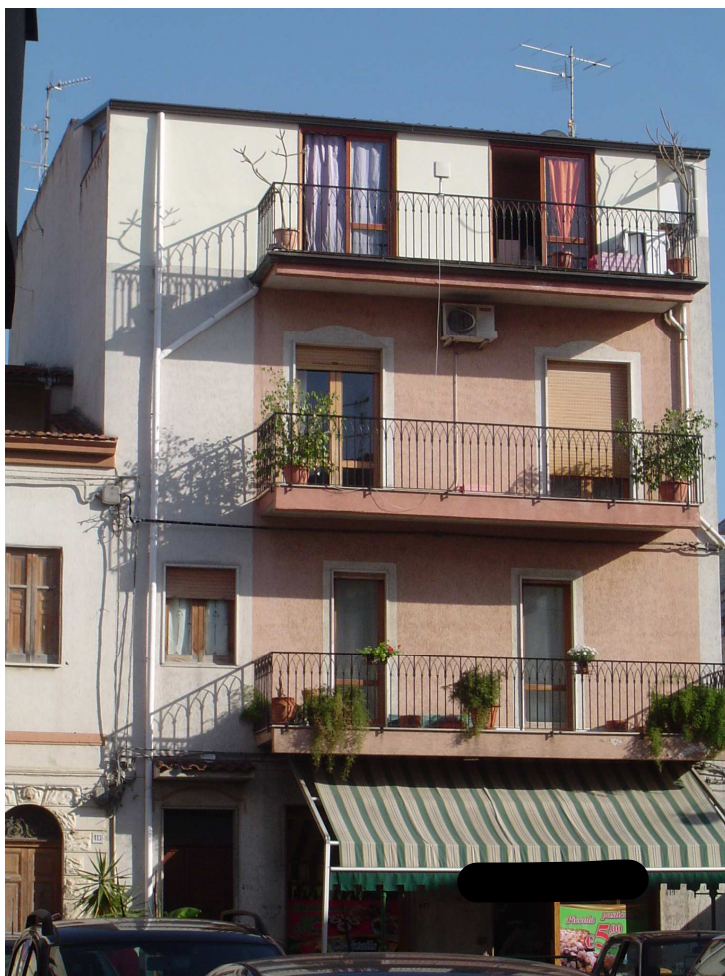
FOTO 1 – Prospetto intero edificio su via Medici;
