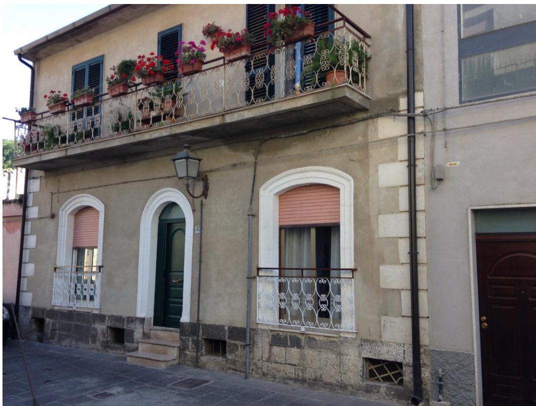
Figura 1- Prospetto di via Vittorio Emanuele III n.67
