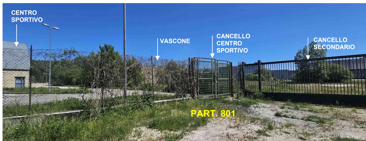
Cancello secondario in prossimità del vascone di accumulo - foto 6
