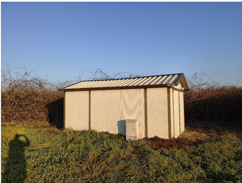
Particolare della cabina del pozzo in piccola parte ricadente sul terreno pignorato
