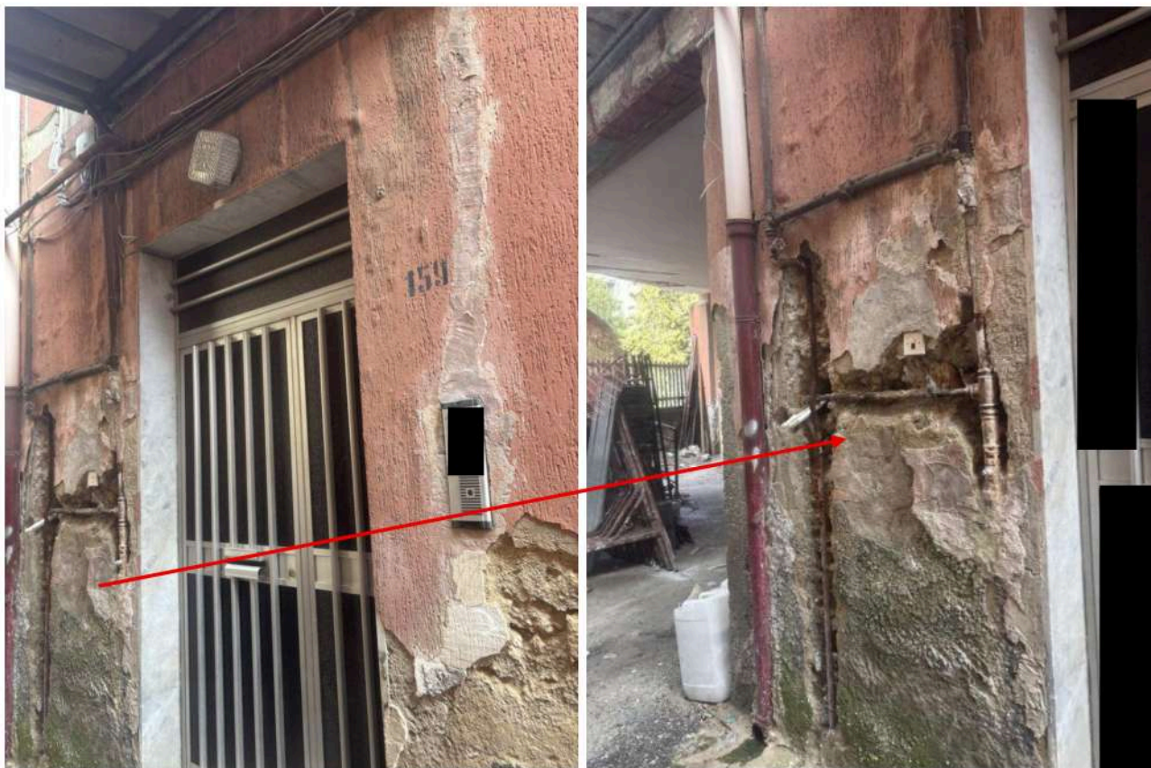
Fig. 10-11: viste prospettiche del portone di accesso al fabbricato al civ. 159 di via Olevano.
