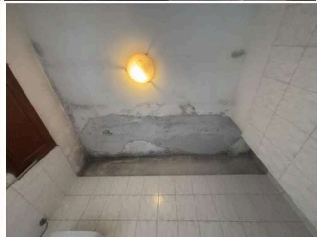
Fig. 35-36-37-38: l'appartamento è servito da un unico ambiente WC di ampie dimensioni provvisto di illuminazione diretta e caldaia, nonché provvisto di antibagno antistante con ripostiglio che non lo rende immediatamente promiscuo rispetto alla zona di ingresso dell'appartamento. Si rilevano, inoltre, nel bagno lavori di rifacimento del solaio che è stato ripreso senza provvedere alle finiture all'intradosso, che risulta crollato a seguito di infiltrazioni d'acqua provenienti dalla copertura.
