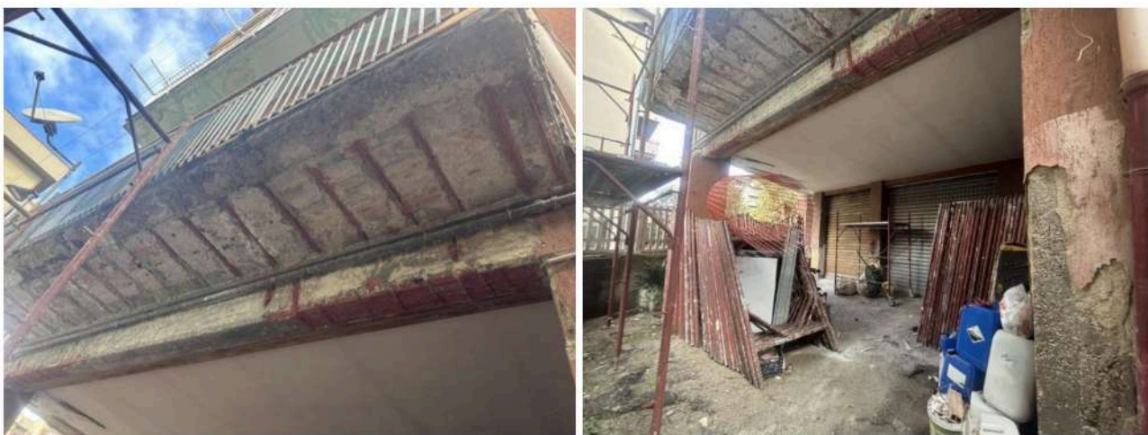
Fig. 12-13: vista prospettiche dello stato di manutenzione straordinaria del fabbricato oggetto di lavori di manutenzione straordinaria che risulta allo stato del primo accesso (05.02.2026) oggetto di lavori di spicconatura dei cornicioni, propedeutici ai lavori di ristrutturazione condominiali, approvati e iniziati nel mese di giugno 2025.
