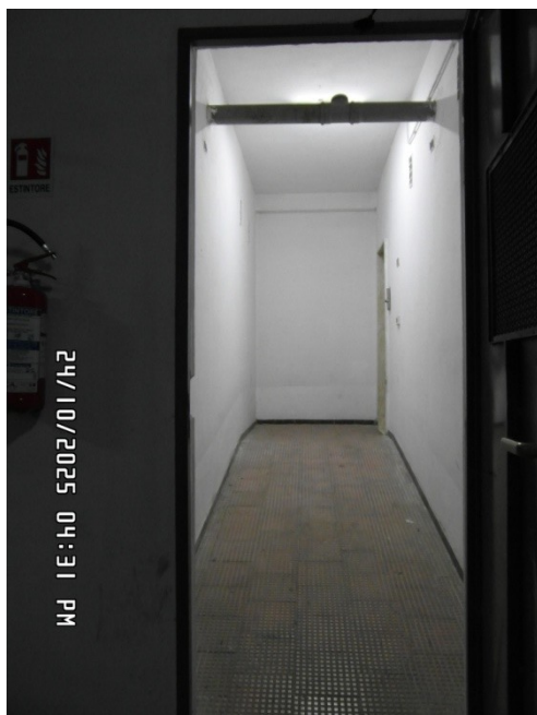
accesso pedonale da vano ascensore
