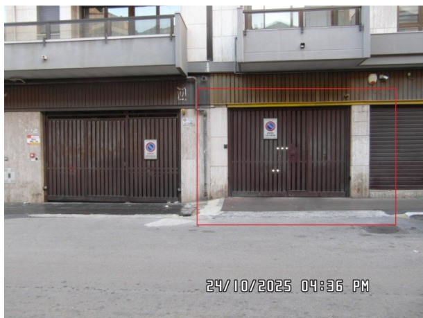
accesso esterno da via Gorizia
