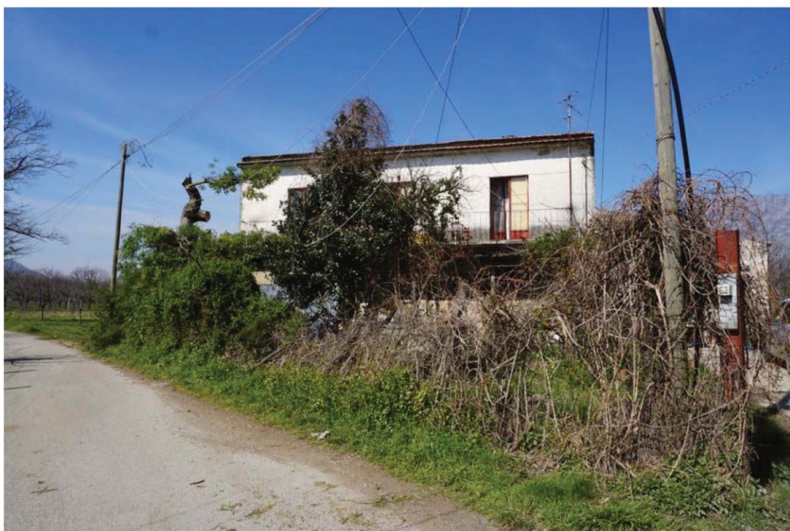
Fig.2 – Vista dell'immobile da est al Fg.37 p.IIa 397 da via Torre
