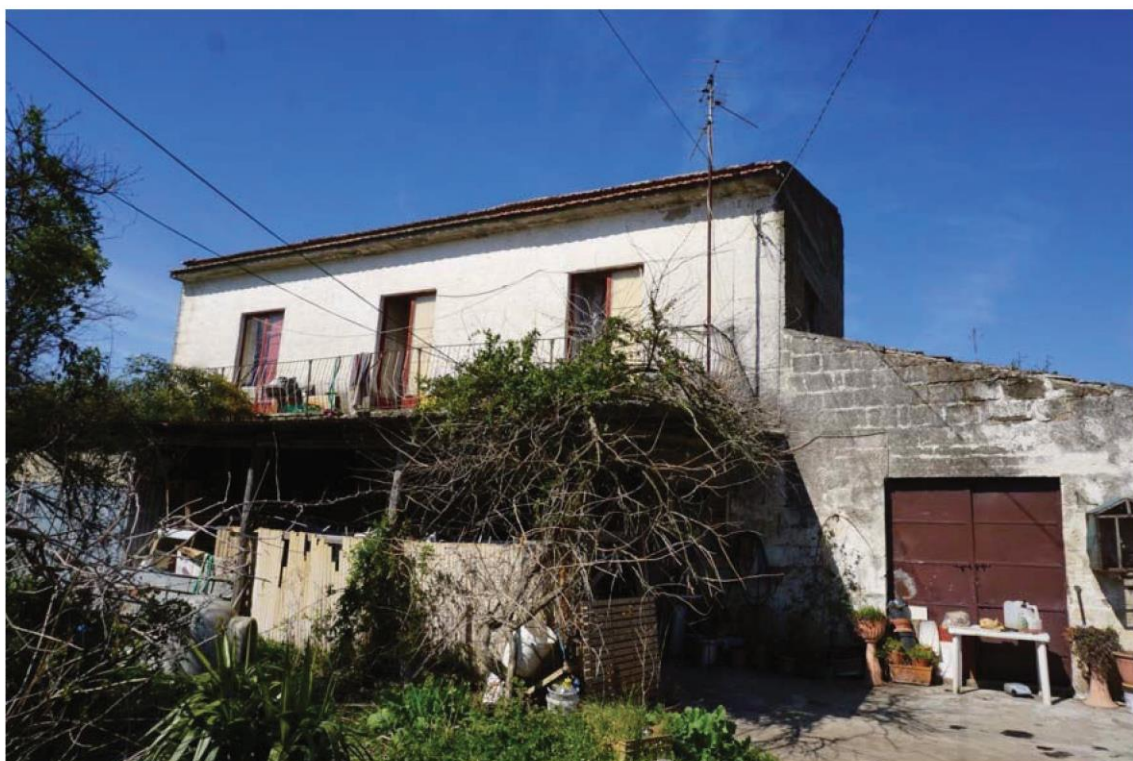
Fig.4 – Vista facciata degli immobili alla p.lla 397 sub.2-3
