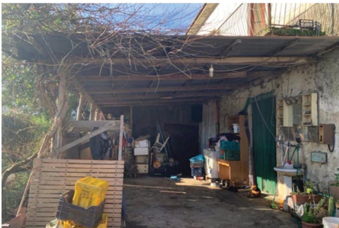
Fig.8 – Vista di dettaglio del portico addossato al sub.2 della p.lla 397
