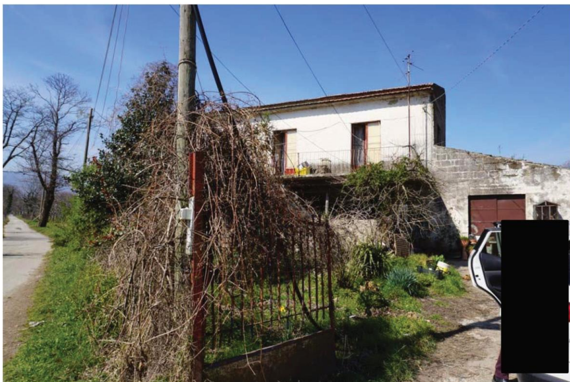
Fig.3 – Vista dell'ingresso dell'immobile
