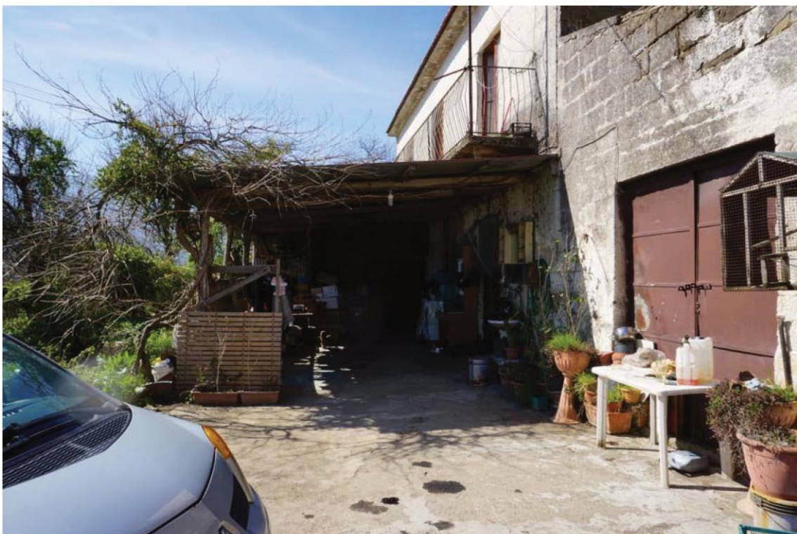
Fig.7 – Vista del portico addossato al sub.2 della p.lla 397
