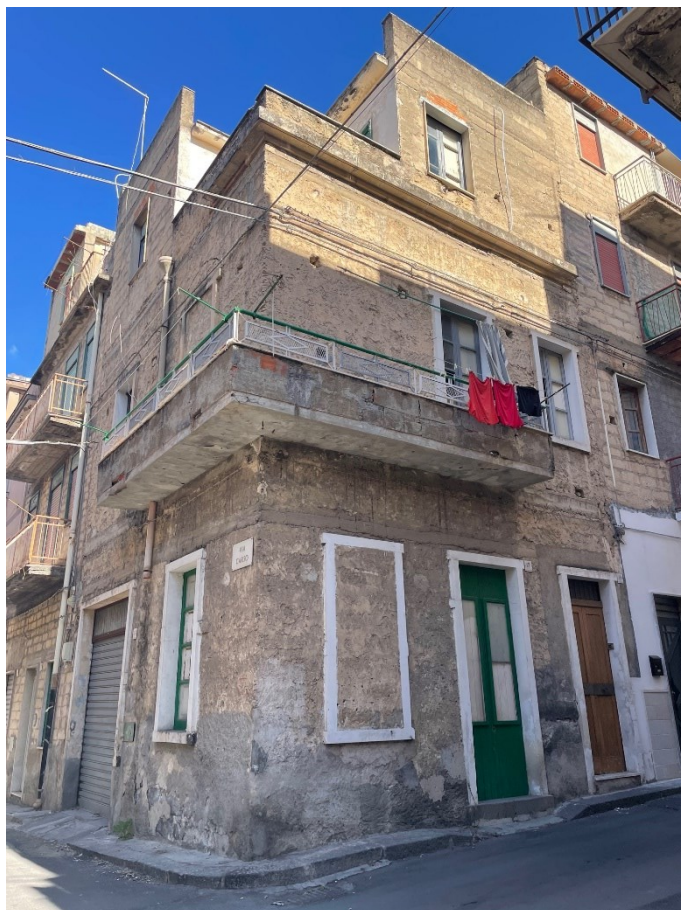
Prospetti sud-est e sud-ovest dell'edificio
