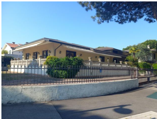
FOTO 2 PROSPETTO EST E NORD
