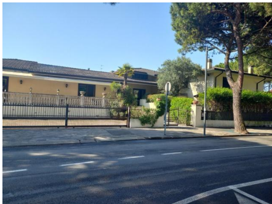
FOTO 1 ENTRATA SU VIA MORONI
