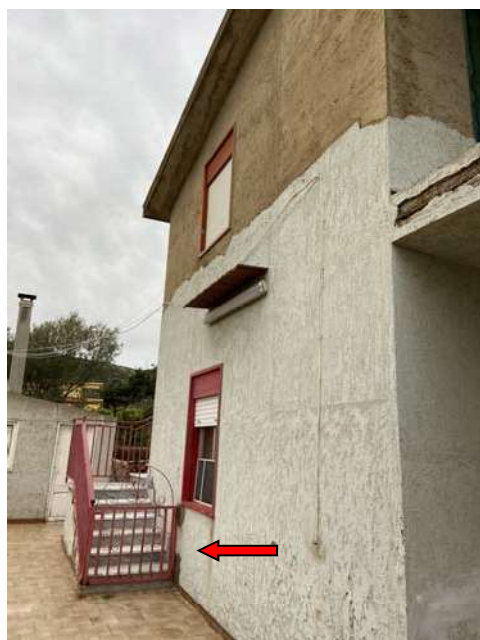
Accesso al piano primo
