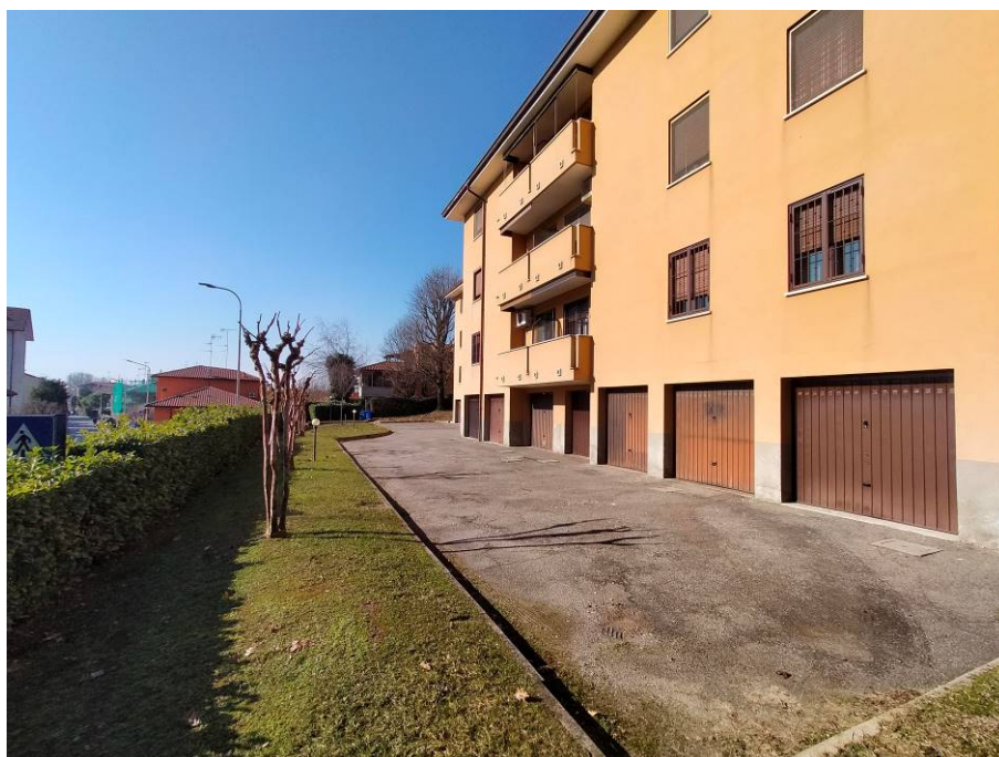
FOTO 4 – vista da cortile interno
