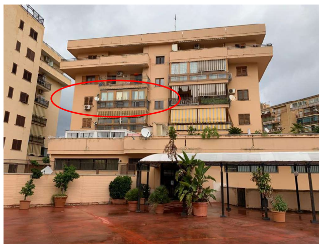
Foto 01 (prospetto interno edificio "E")
