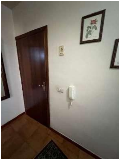
Foto n° 14 Rifiniture ed impianti
