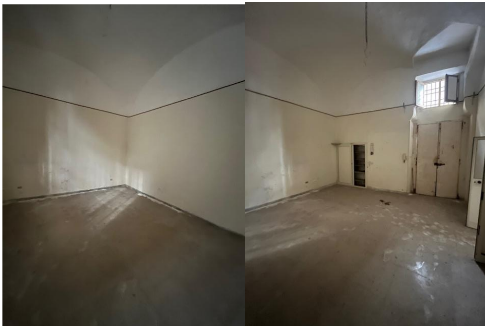
Foto 19,20. Interno secondo vano immobile
