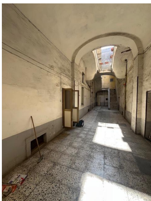
Foto 1. – Foto 2. Esterno palazzo Foto 3. – Foto 4. Esterno palazzo ed androne ingresso
