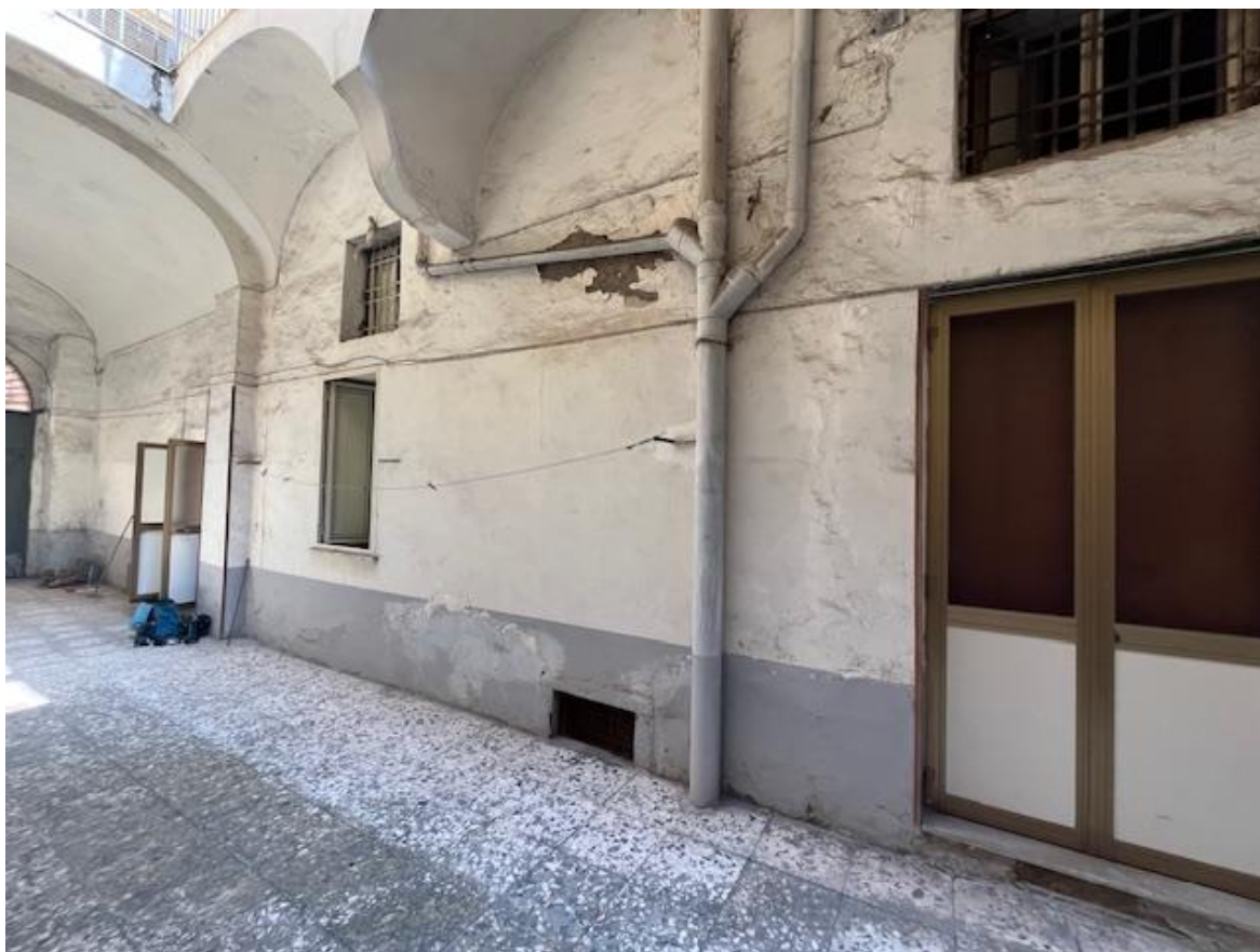
Foto 5. Foto 6 Prospetti interni su androne interno condominiale
