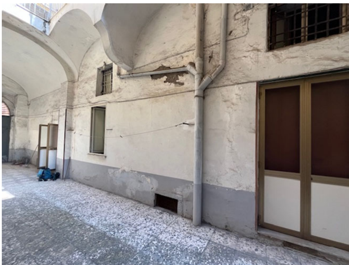
Foto 5. Foto 6 Prospetti interni su androne interno condominiale
