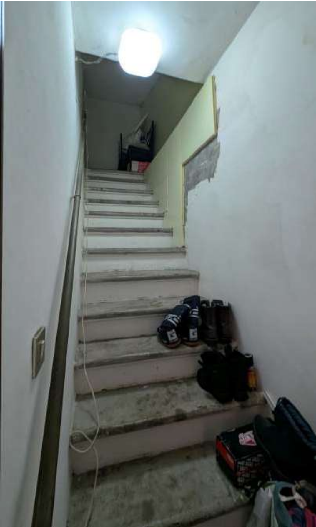
Rampa di collegamento tra il Piano Primo e Piano Secondo
