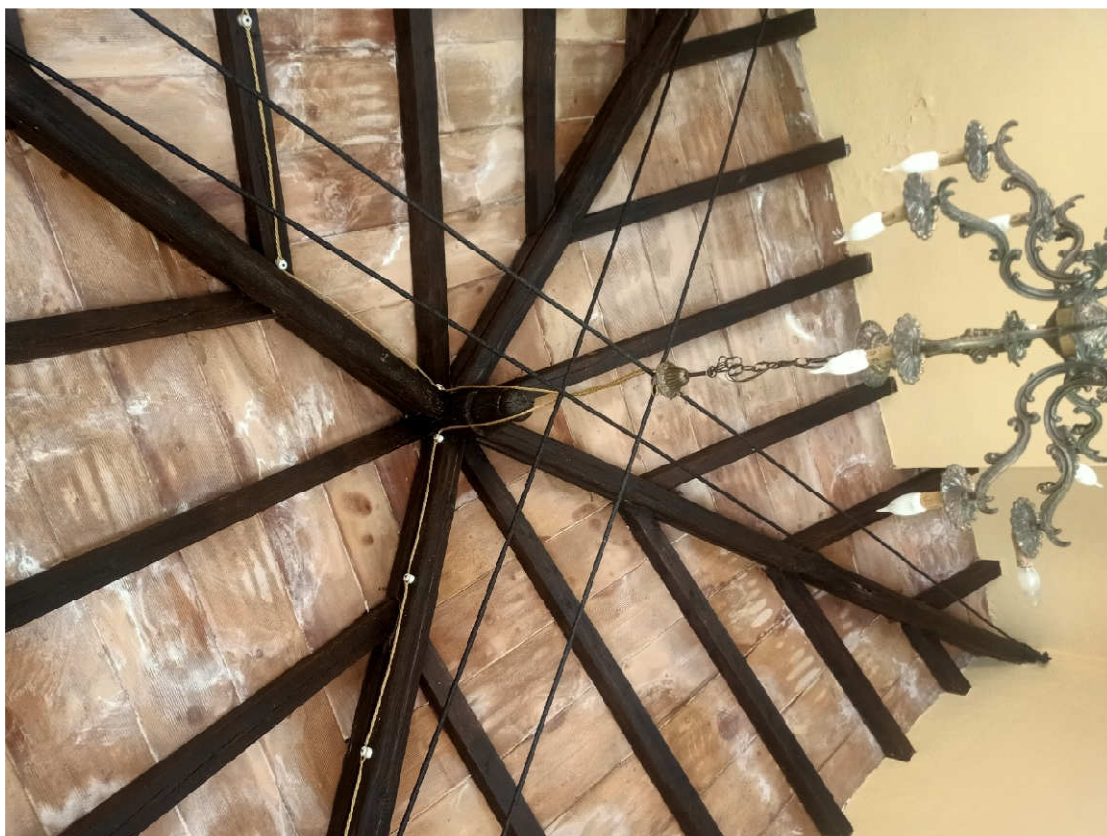
Particolare copertura altana
