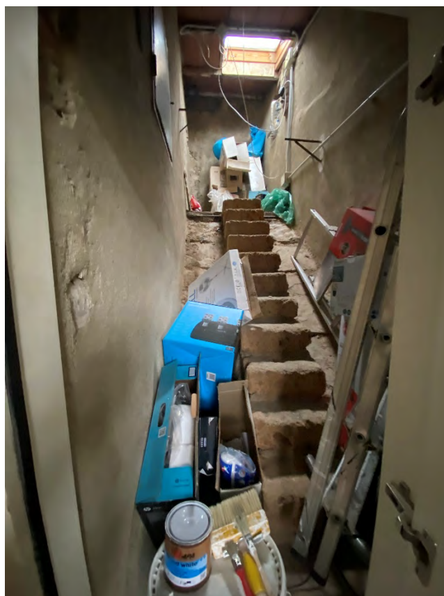
FOTO 12 - SOTTOTETTO- ACCESSO ALLA COPERTURA
