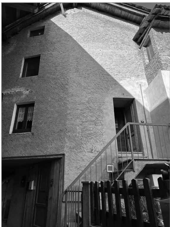
Foto 3 – facciata ovest, scala esterna accesso
