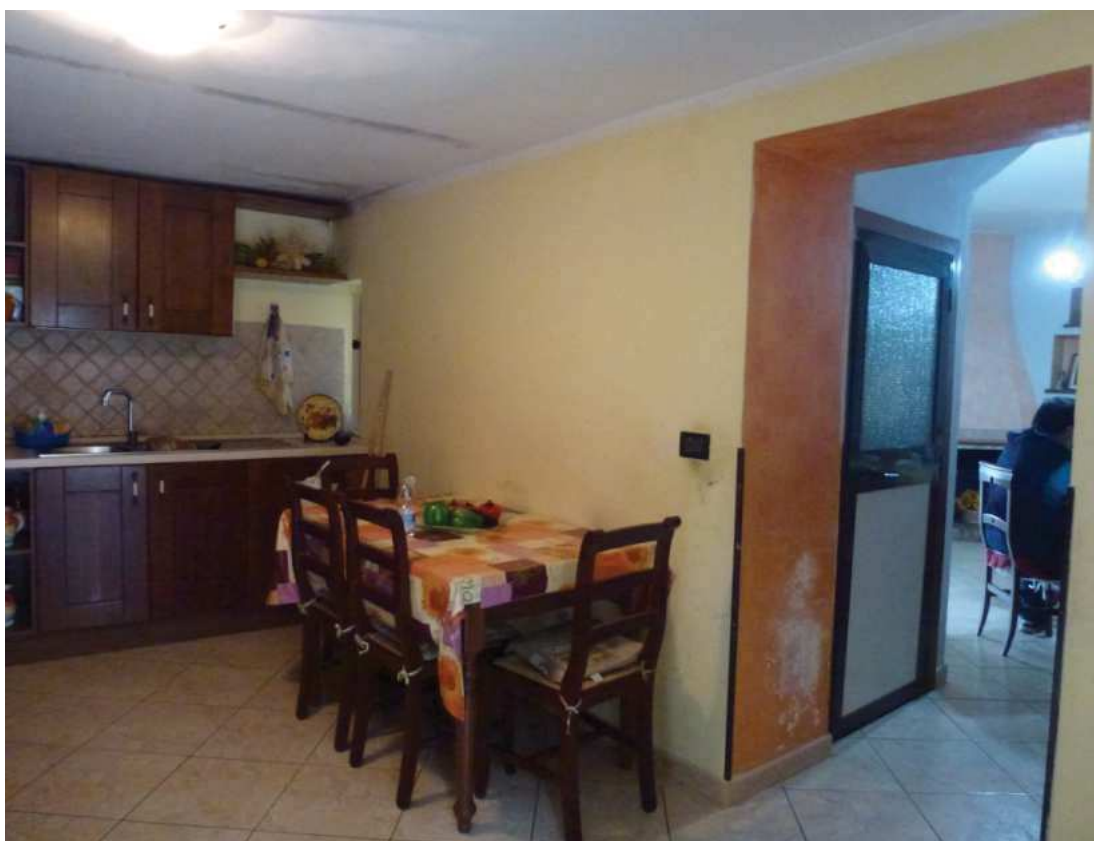
Foto 30 – P.I. Locale K
