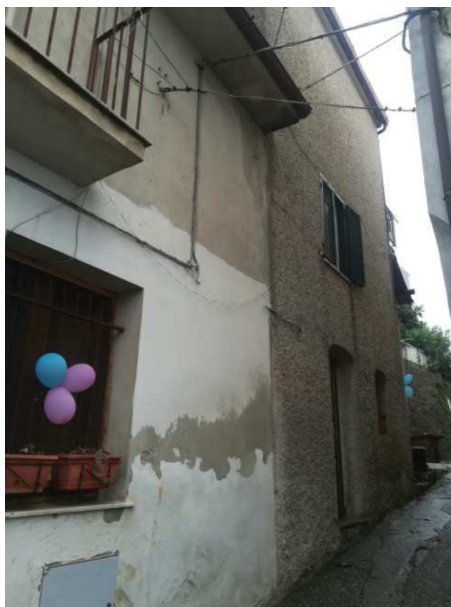
Foto 2 - Prospetto lato Ovest
