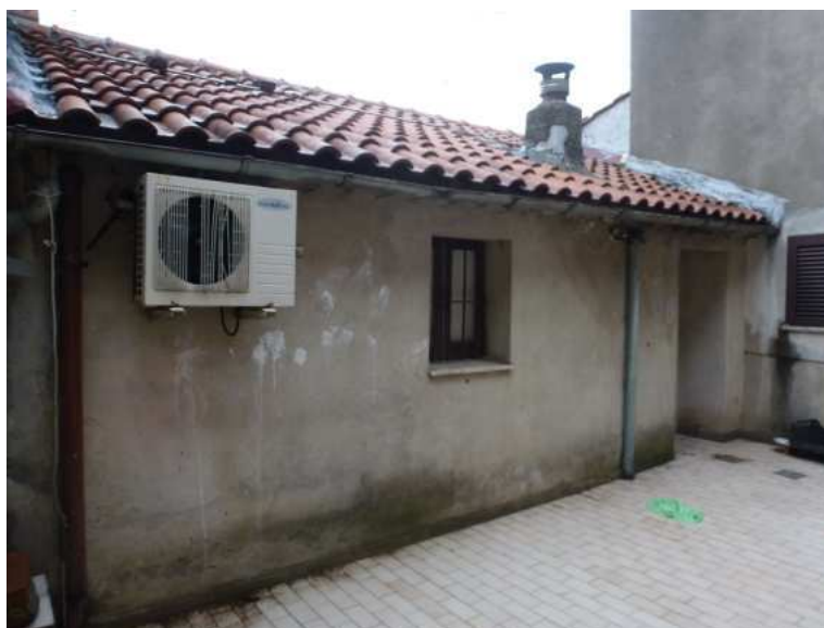
Foto 4 - Prospetto lato Est (retro)
