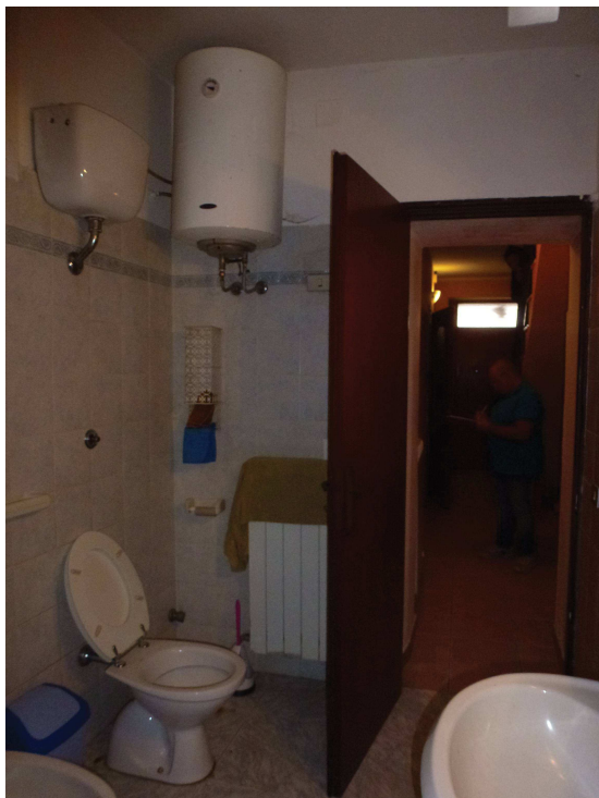
Foto 14 – P.T. locale WC
