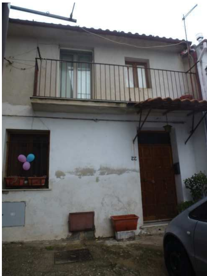
Foto 1 - Prospetto lato Ovest
