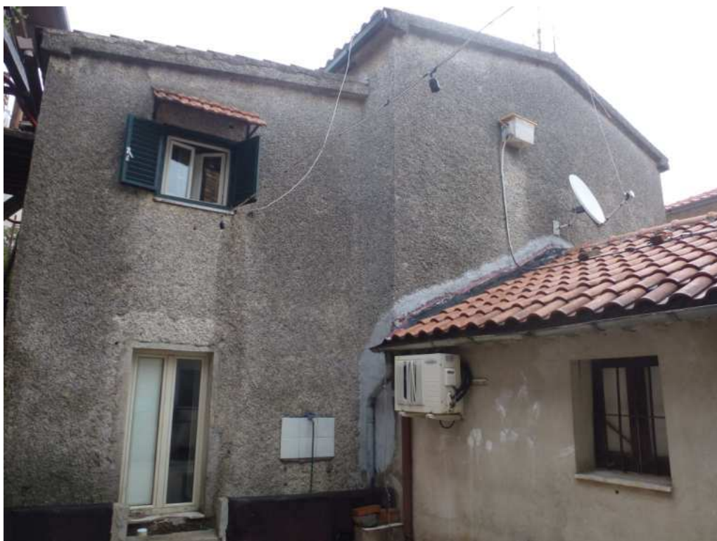
Foto 5 - Prospetto lato Sud (retro)
