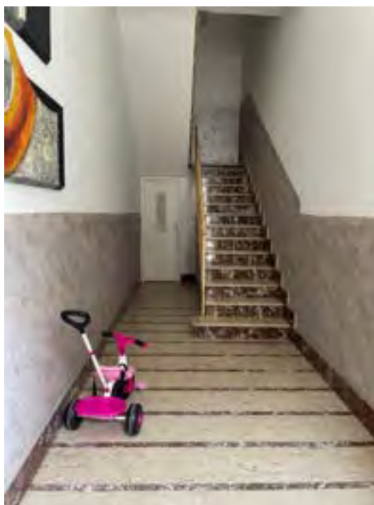
Vano scala dell'edificio bifamiliare
