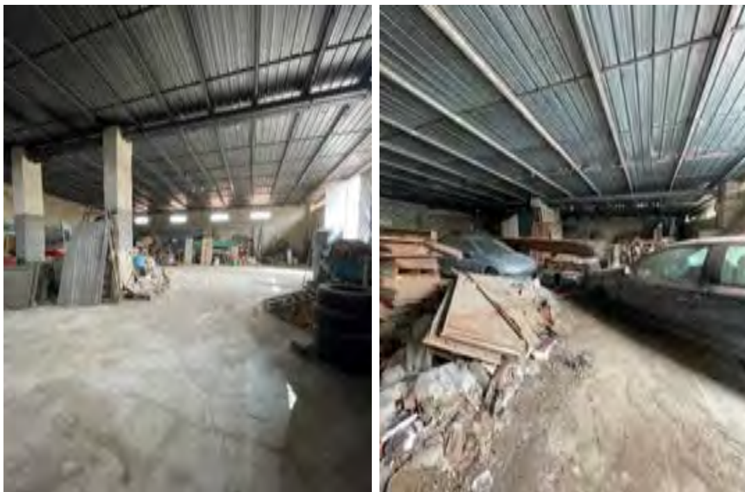
Interno dei magazzini
