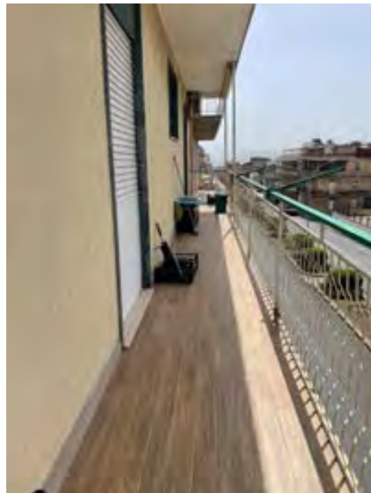
Balcone al piano secondo
